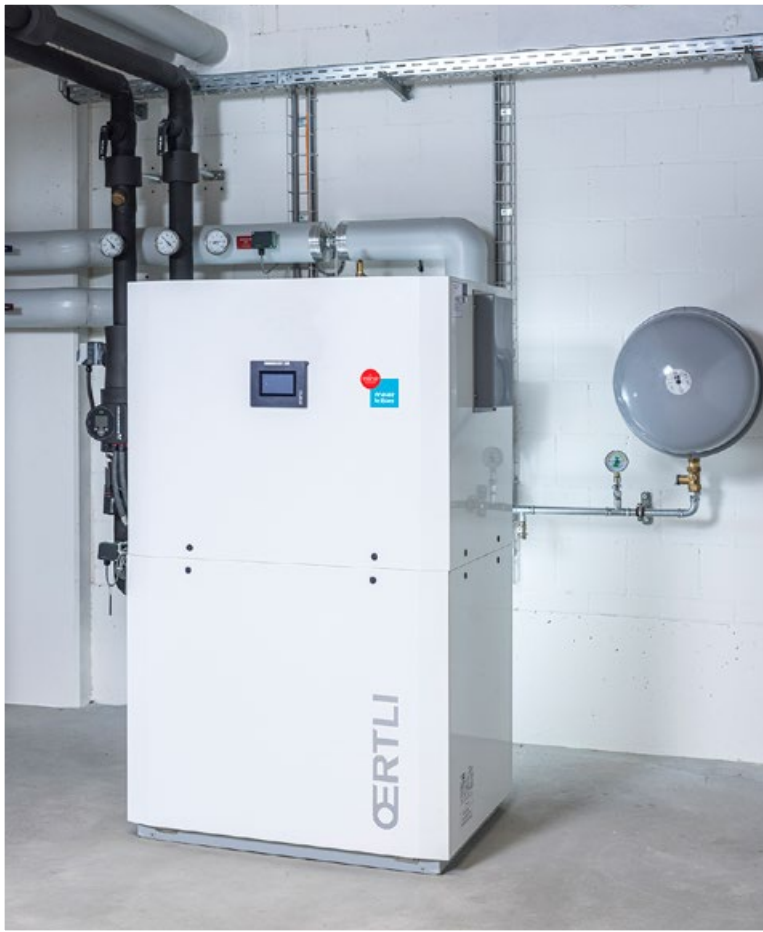
Eindruckliche Installation: Eine Wärmepumpe Oertli SINH 20TE (links), zwei 6000-Liter-Individualspeicher Heizung Meier Tobler (ganz oben) und zwei 6000-Liter-Individualspeicher Kälte Meier Tobler (oben).
