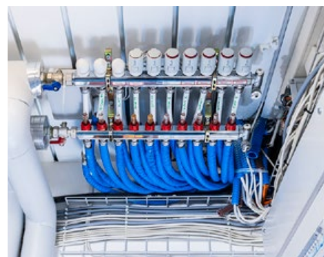
Wanja Greuel (Bild links, ganz rechts) erhält von Anton Helscher (Mitte) und Roger Eyholzer alle wichtigen Informationen zur neuen Heizanlage, zu der auch eine neue Fussbodenheizung gehört, deren Verteiler ebenfalls im Heizkeller untergebracht ist (Bild oben).
