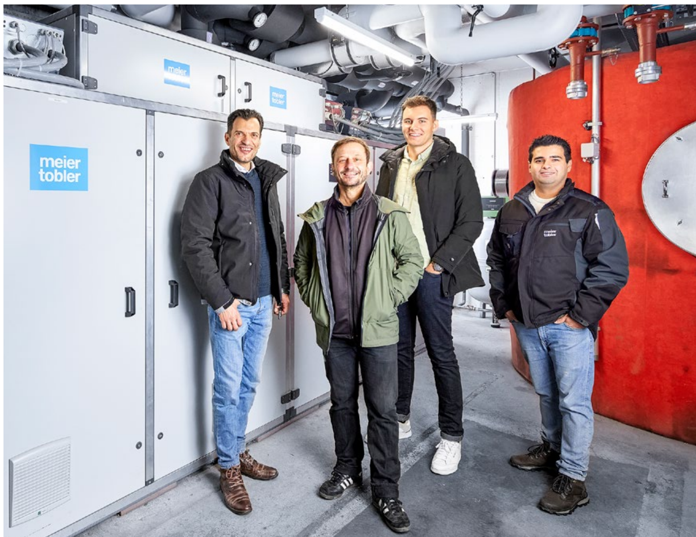
Ein zufriedenes Quartett: Imran Emruli (Equans Services AG), Peter Gadola (Bauherrschaft), Marc Sturzenegger (Sustech AG) und Denis Pereira (Meier Tobler). (Bilder: ss)
