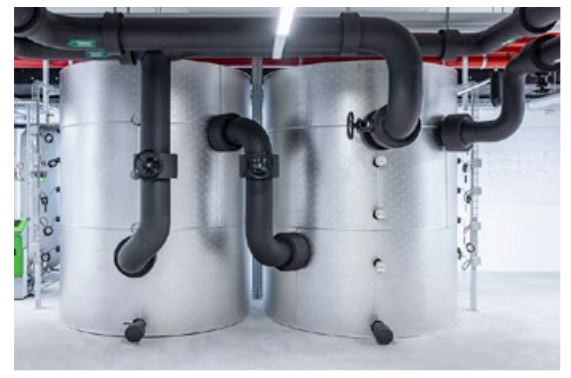
Eindruckliche Installation: Eine Wärmepumpe Oertli SINH 20TE (links), zwei 6000-Liter-Individualspeicher Heizung Meier Tobler (ganz oben) und zwei 6000-Liter-Individualspeicher Kälte Meier Tobler (oben).
