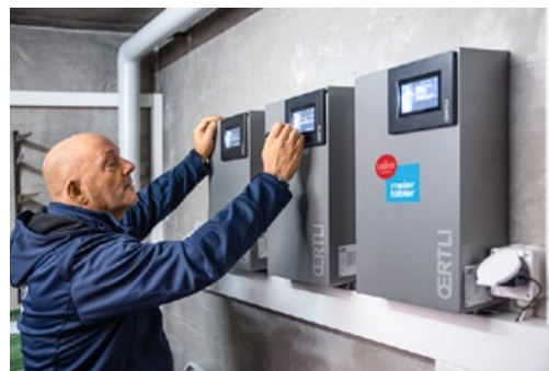
Die drei Wärmepumpen stehen für die Zukunft (links). Aufgeräumte Installation im engen Heizkeller (ganz oben) und Inbetriebnahme durch Nicola Ghielmetti (oben).
