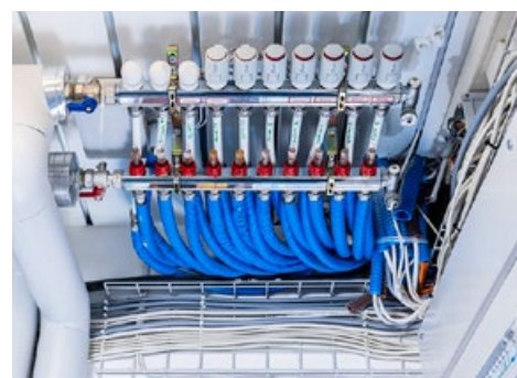
Wanja Greuel (à droite sur la photo ci-contre) reçoit d'Anton Hellscher (au centre) et de Roger Eyholzer toutes les informations importantes sur la nouvelle installation de chauffage, qui comprend notamment un nouveau système de chauffage au sol, dont le collecteur se trouve également dans la chaufferie (photo ci-dessus).
