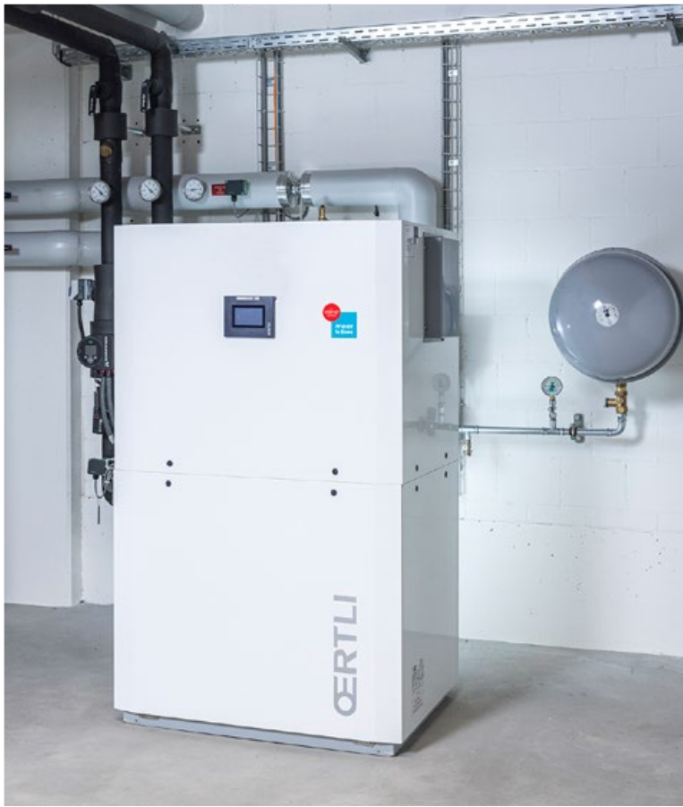
Installation impressionnante : 1 pompe à chaleur Oertli SINH 20TE (ci-contre), deux accumulateurs individuels de chauffage Meier Tobler de 6000 litres chacun (en haut) et deux accumulateurs individuels de froid Meier Tobler de 6000 litres chacun (ci-dessus).
