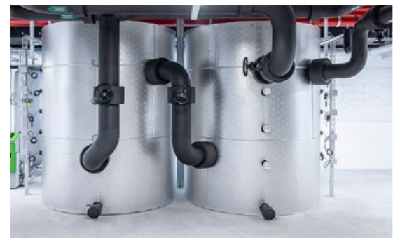
Installation impressionnante : 1 pompe à chaleur Oertli SINH 20TE (ci-contre), deux accumulateurs individuels de chauffage Meier Tobler de 6000 litres chacun (en haut) et deux accumulateurs individuels de froid Meier Tobler de 6000 litres chacun (ci-dessus).
