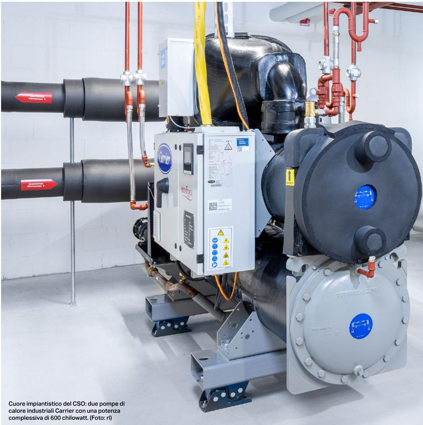
Cuore impiantistico del CSO: due pompe di calore industriali Carrier con una potenza complessiva di 600 chilowatt. (Foto: rl)
