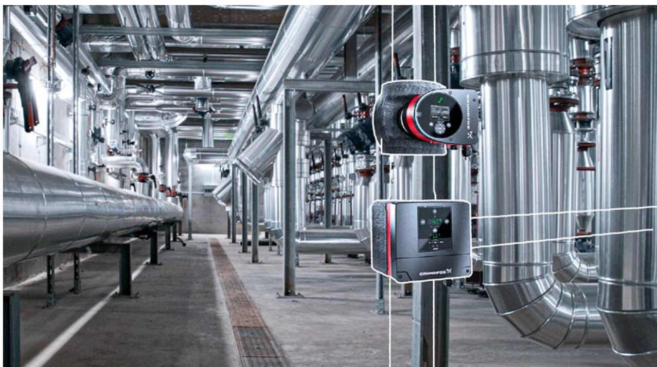
La soluzione completa richiede solo due componenti: l'unità Grundfos MIXIT e una pompa Grundfos MAGNA3 o TPE3. Gli installatori possono così realizzare circuiti di miscelazione ottimali in modo rapido e semplice.
