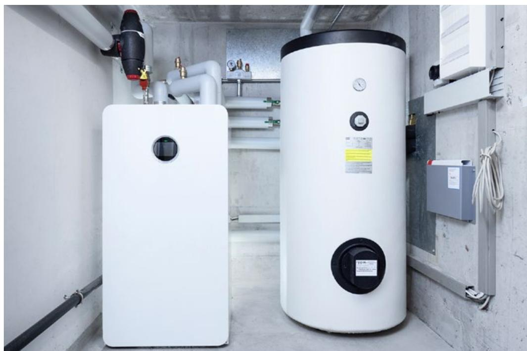
Tutto nuovo nel locale tecnico: l'unità interna della pompa di calore e lo scaldacqua.
