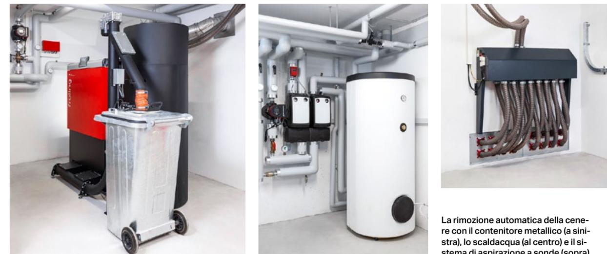
La rimozione automatica della cenere con il contenitore metallico (a sinistra), lo scaldacqua (al centro) e il sistema di aspirazione a sonde (sopra).
