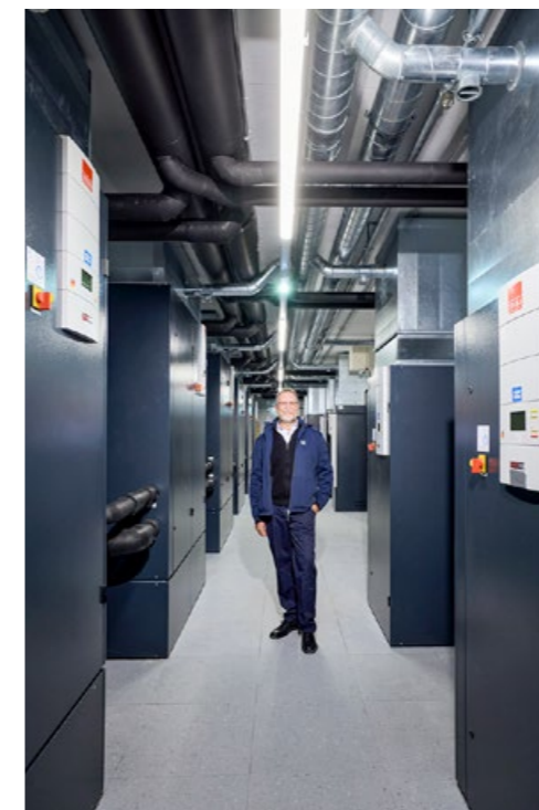
La production de froid est assurée par les machines Carrier (ci-dessus), la climatisation des nombreuses salles informatiques par les armoires climatiques de Stulz (ci-contre).
