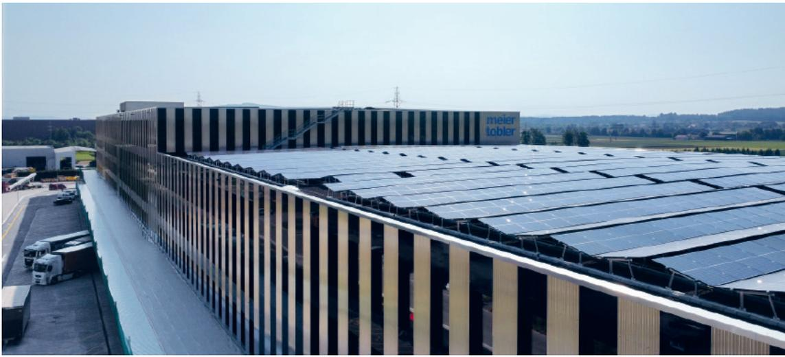
Die Photovoltaik-anlage besteht aus 4953 Solarmodulen, die zusammen 2 Megawatt Peak leisten. Die Anlage auf dem DCO ist seit April 2023 am Netz und ist eines der grössten Solar-kraftwerke der Schweiz.
