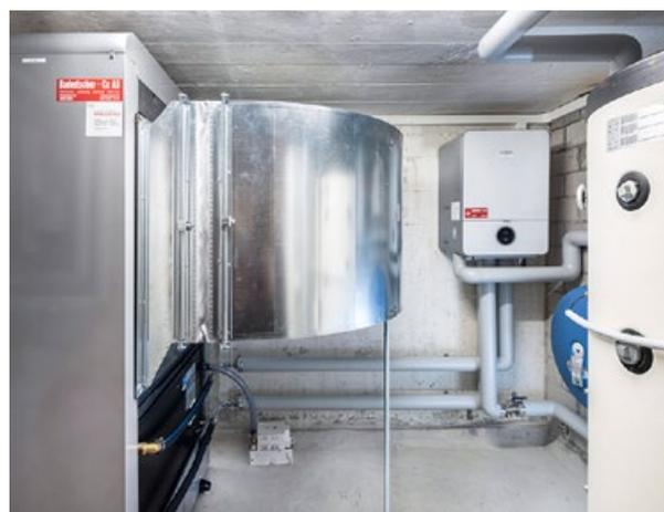
En haut : grâce à ses dimensions extrêmement compactes, la nouvelle pompe à chaleur a pu être installée dans l'ancien local à citerne.
