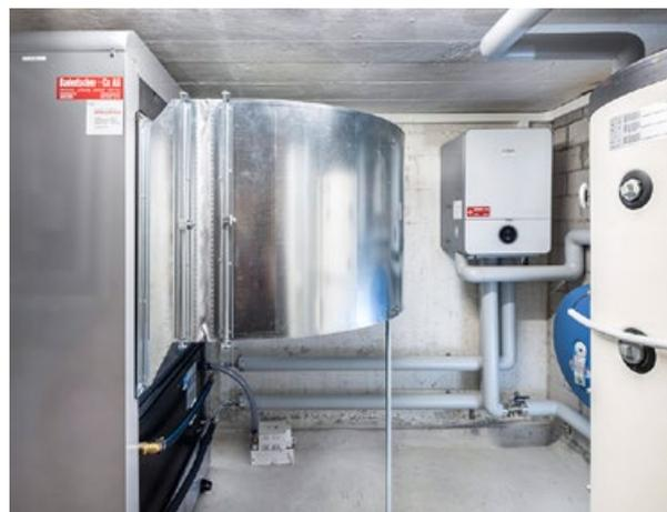
Oben: Dank ihren extrem kompakten Abmessungen konnte die neue Wärmepumpe im früheren Tankraum untergebracht werden.
