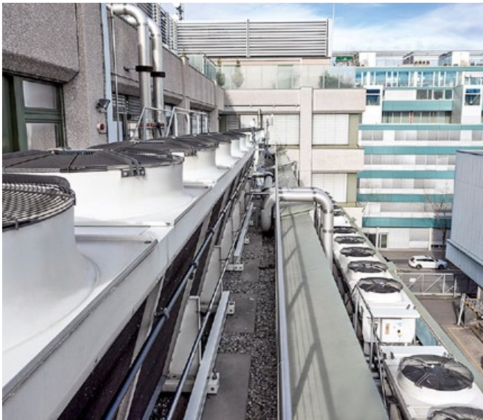
Links: Stark gekühlt: acht Rückkühler Xchange ETEC 1510 auf dem Dach.
