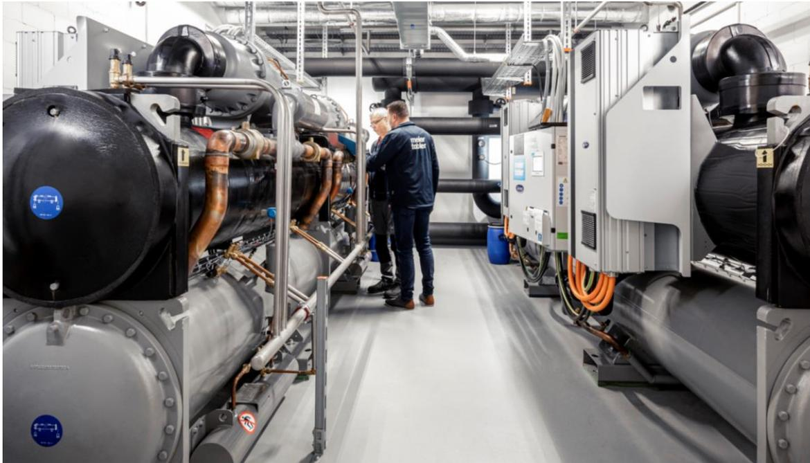
Kantonsapotheke Zürich, zwei Carrier-Kältemaschinen mit HFO-Kältemitteln (2x400kW)
