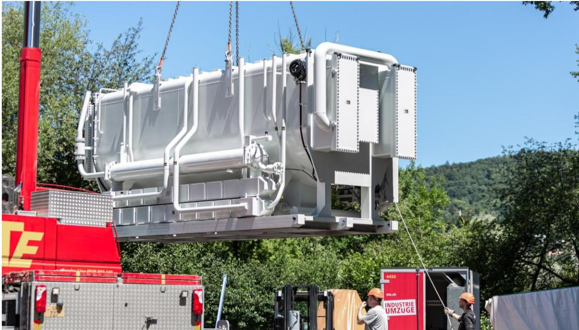
Wärmeverbund Limmattal, Gross-Wärmepumpe (13,2 MW)
