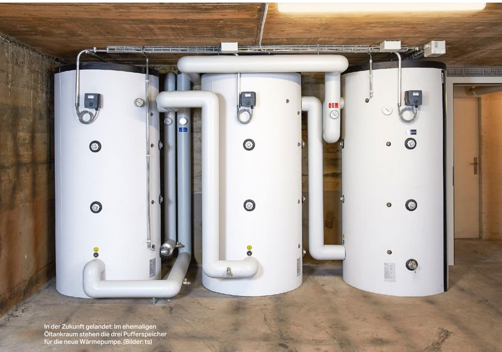
In der Zukunft gelandet: Im ehemaligen Öltankraum stehen die drei Pufferspeicher für die neue Wärmepumpe. (Bilder: ts)
