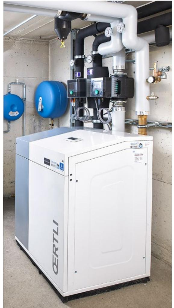
Die Leistung der Oertli SI-GEO SQ für Raumwärme respektive Warmwasser kann stufenlos an das Objekt angepasst werden.
