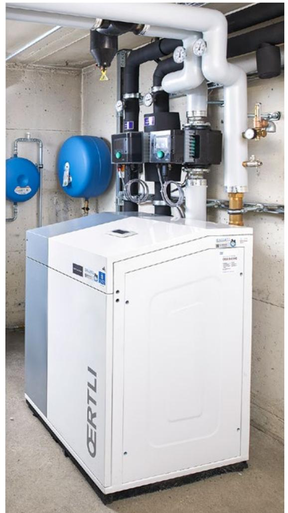
La puissance de l'Oertli SI-GEO SQ peut être adaptée en continu aux besoins effectifs du bâtiment, aussi bien pour le chauffage que pour la production d'eau chaude.
