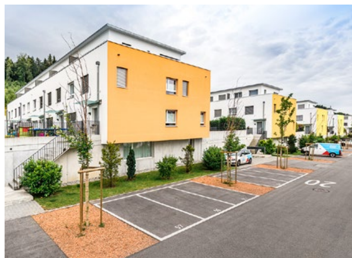
Le prime pompe di calore delle case a schiera nel quartiere di Oberfeld sono ora collegate a «smart-guard».
