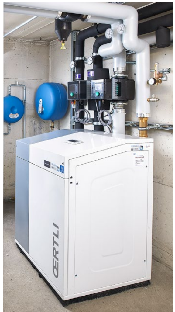
La potenza della Oertli SI-GEO SQ per il riscaldamento ambiente e l'acqua calda può essere adattata in continuo in funzione dell'oggetto.
