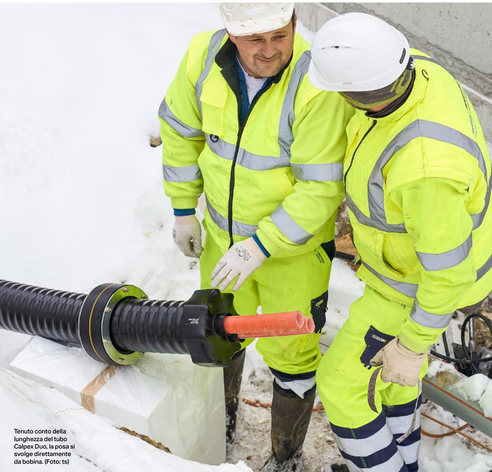
Tenuto conto della lunghezza del tubo Calpex Duo, la posa si svolge direttamente da bobina. (Foto: ts)
