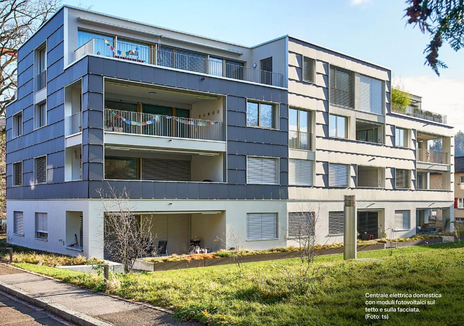
Centrale elettrica domestica con moduli fotovoltaici sul tetto e sulla facciata. (Foto: ts)
