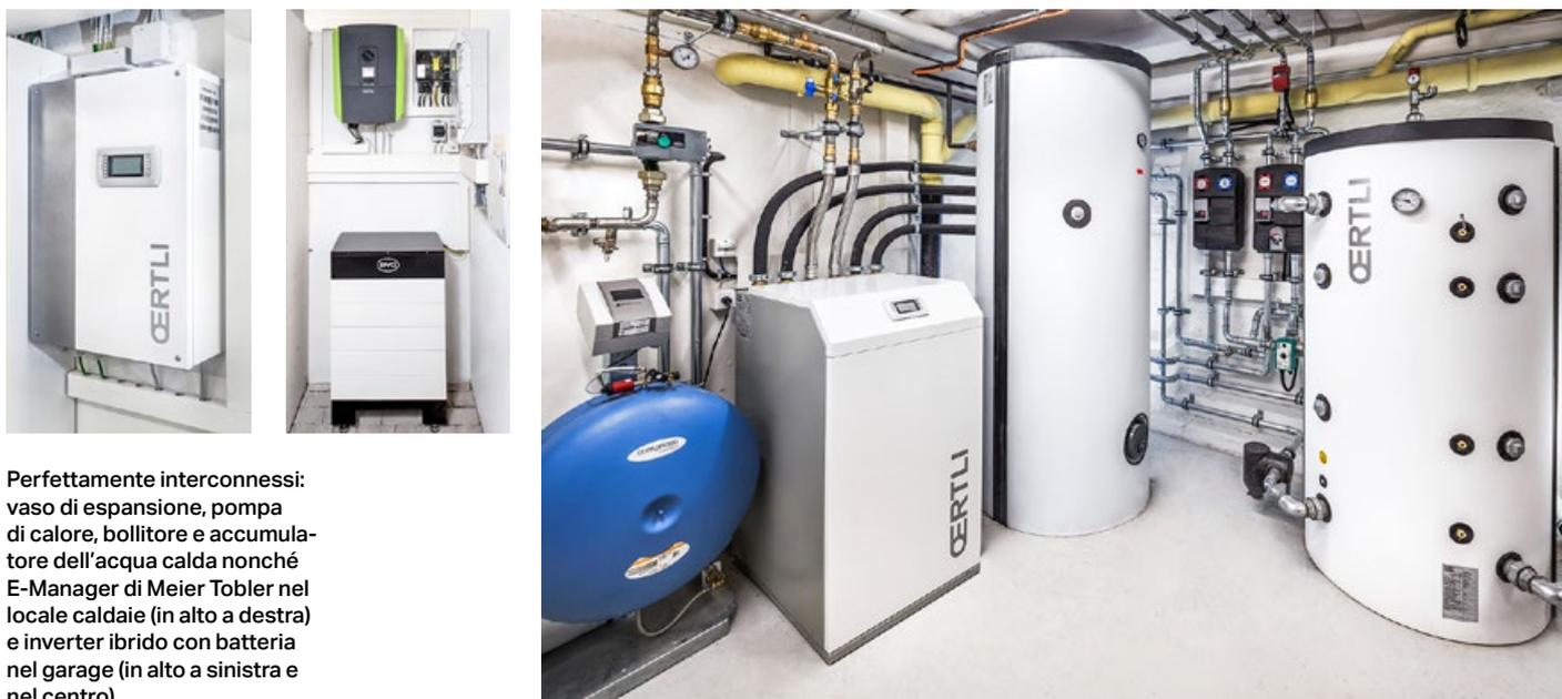
Perfettamente interconnessi: vaso di espansione, pompa di calore, bollitore e accumulatore dell'acqua calda nonché E-Manager di Meier Tobler nel locale caldaie (in alto a destra) e inverter ibrido con batteria nel garage (in alto a sinistra e nel centro).
