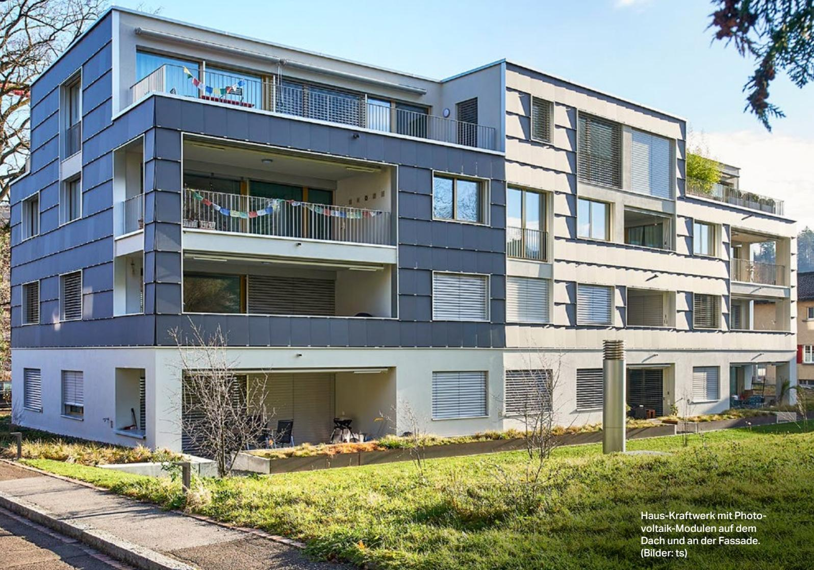
Haus-Kraftwerk mit Photovoltaik-Modulen auf dem Dach und an der Fassade. (Bilder: ts)
