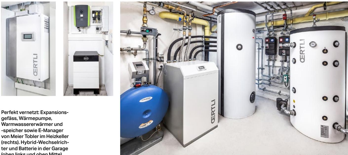
Perfekt vernetzt: Expansionsgefäß, Wärmepumpe, Warmwassererwärmer und -speicher sowie E-Manager von Meier Tobler im Heizkeller (rechts). Hybrid-Wechselrichter und Batterie in der Garage (oben links und oben Mitte).
