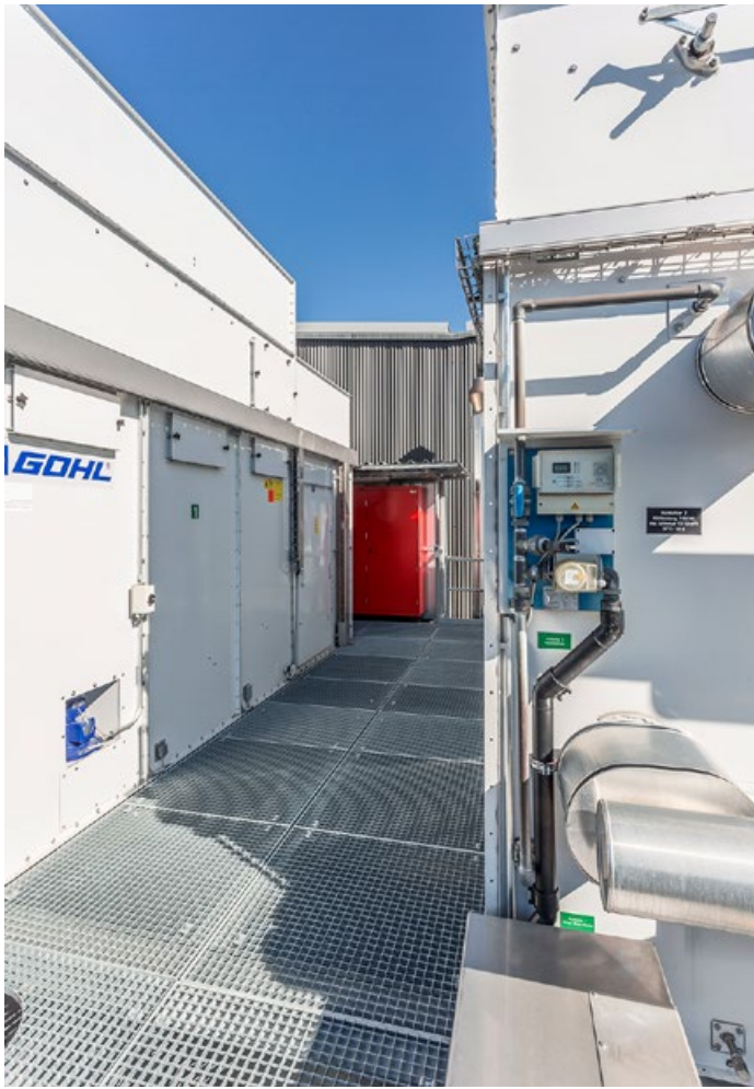
Les deux tours de refroidissement (en bas), la zone intermédiaire (à gauche) et vue à l'intérieur (à droite) avec le ventilateur (blanc) et le moteur électrique (bleu).
