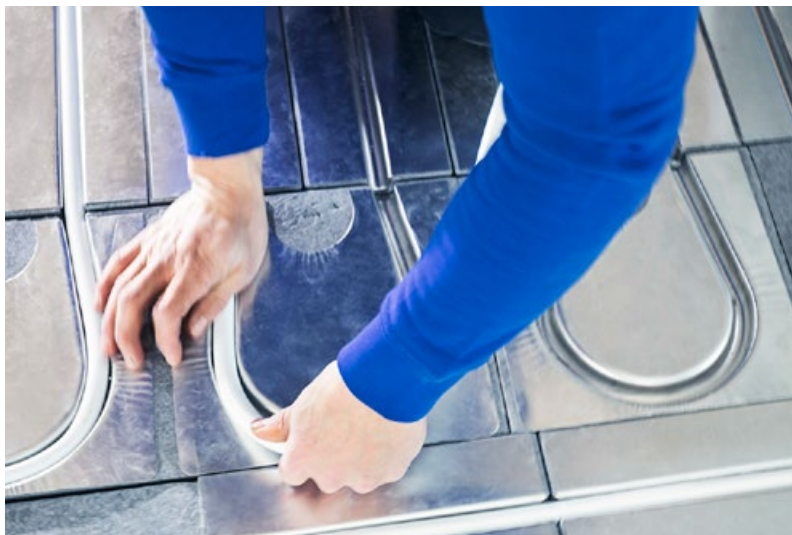
Une diffusion de chaleur optimale grâce à des lamelles en aluminium.
