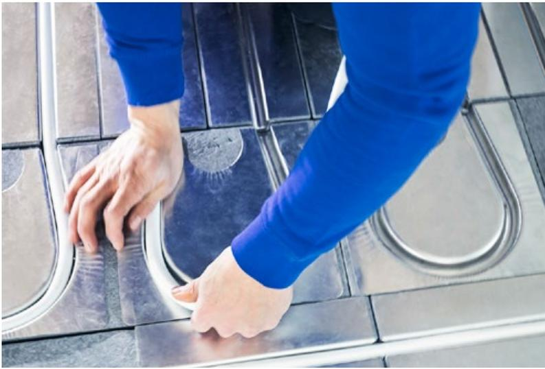
Optimale Wärmeabgabe dank Aluminiumleitlamellen.
