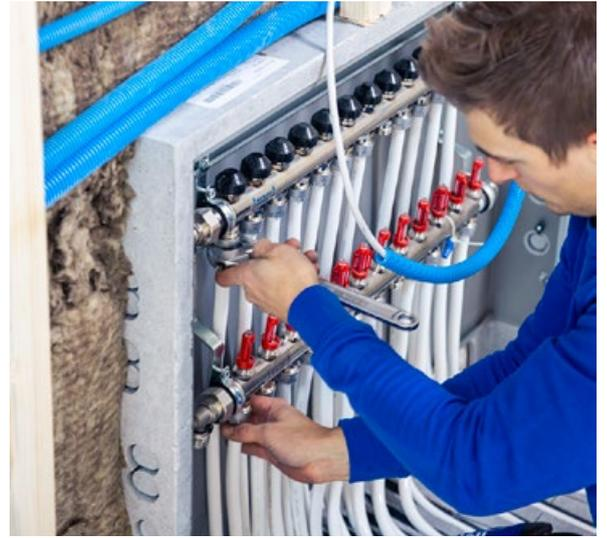
Einfach und schnell am Verteiler angeschlossen.
