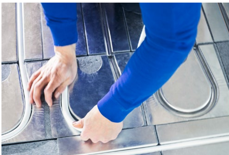
Cessione ottimale del calore grazie ai profili termoconduttori in alluminio.
