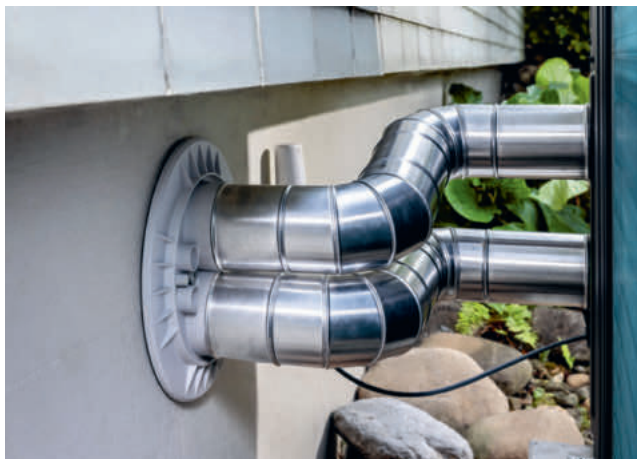
Dove prima c'era la cisterna del gasolio ora c'è il nuovo impianto di riscaldamento (in alto a sinistra), collegato all'unità esterna tramite il passaggio murale Doymafix HP/O (sopra a sinistra). Soddisfatti del risultato (da sinistra): Philipp Burri, Ernst Gukelberger, Ernst Jenni e Thomas Schneider.
