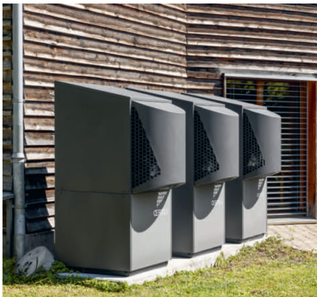
Le tre pompe di calore aria-acqua Oertli LAN 35TBS davanti all'edificio (in alto) e il locale tecnico con l'accumulatore di calore Oertli SHW 1501 da 1500 litri (sopra a destra). La caldaia a pellet Fröling P4 con una potenza di 100 kilowatt (sotto a destra).
