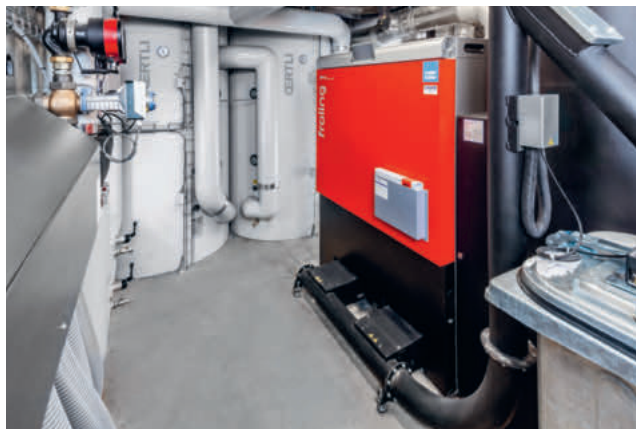
Le tre pompe di calore aria-acqua Oertli LAN 35TBS davanti all'edificio (in alto) e il locale tecnico con l'accumulatore di calore Oertli SHW 1501 da 1500 litri (sopra a destra). La caldaia a pellet Fröling P4 con una potenza di 100 kilowatt (sotto a destra).
