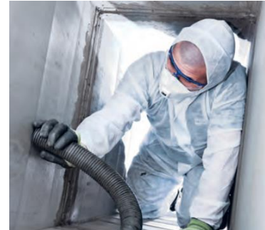
Lüftungs- und Boiler- Reinigungen
