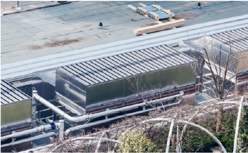
Der Gohl HK ist ein wegweisendes System ohne Sekundärkreislauf. Es wird nur so viel Wasser versprüht, wie auch verdunstet. Dadurch entsteht keinerlei Eindickung beim Sprühwasser und es gibt keinerlei Bedarf an Abschlammwasser.
