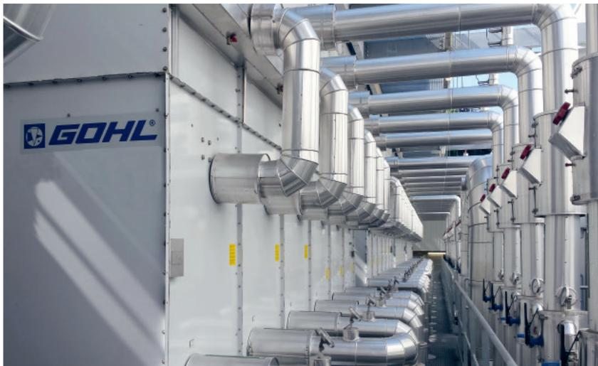
Echter geschlossener Kühlturm, der mit entsprechenden Massnahmen, auch ohne Glykol, als reine Wassermaschine zu betreiben ist. Mit dieser Technologie können auch feinste Kühlkanäle in der Maschinenindustrie gekühlt werden. Diese Geräte sind Hybridbetriebsfähig und können trocken wie nass betrieben werden.
