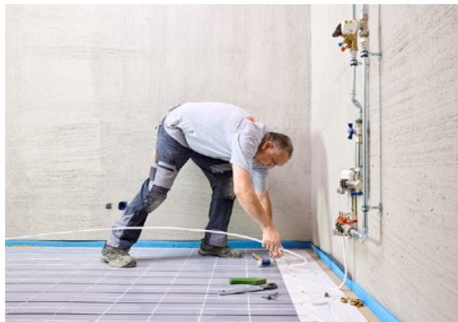
Pose du tube composite et raccordement aux circuits de chauffage.
