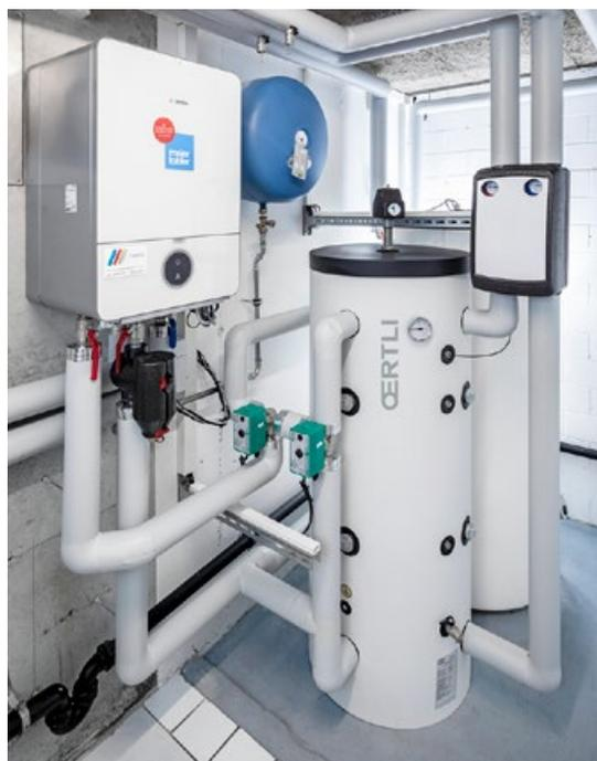
Unité intérieure de la pompe à chaleur air-eau Bosch CS7400iAW avec accumulateur d'eau de chauffage Oertli SHW 307.
