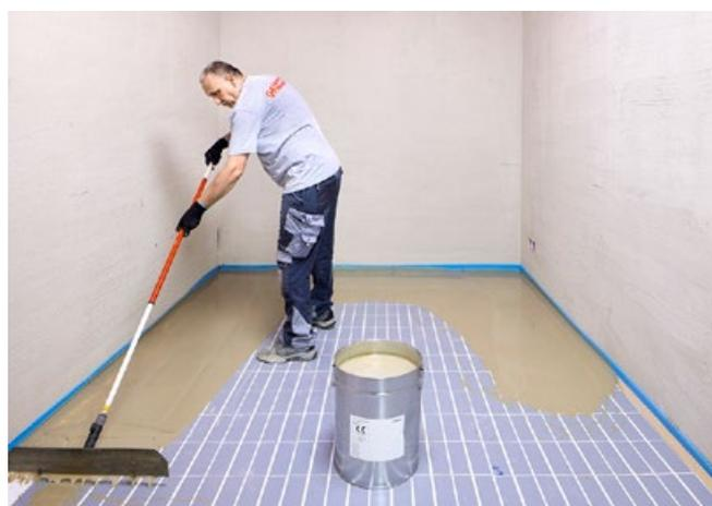
A l'aide d'un grand racloir, répartition de la masse à base de résine et de quartz.
