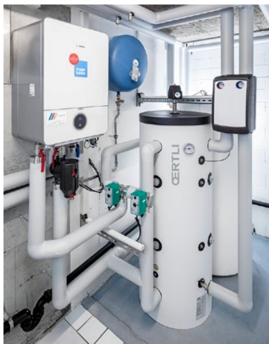
L'unità interna della pompa di calore Bosch CS7400iAW con l'accumulatore per l'acqua di riscaldamento Oertli SHW 307.
