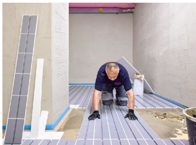
Posa millimetrica degli elementi scaldanti tagliati a misura.
