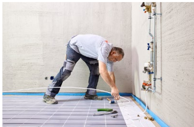
Inserimento del tubo multistrato e collegamento al collettore di distribuzione.
