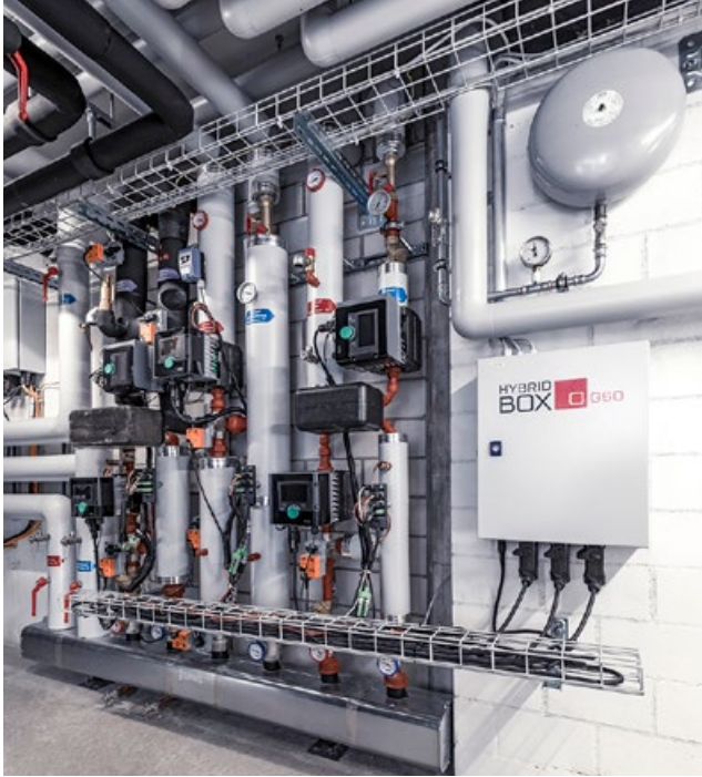
Gruppi riscaldamento configurati in modo specifico per la Hybridbox. (Foto: rl)
