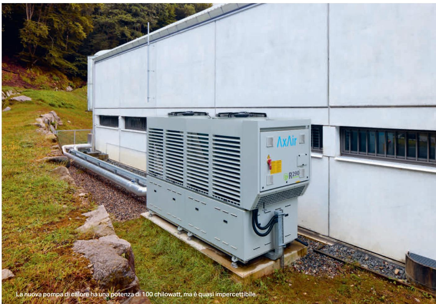
La nuova pompa di calore ha una potenza di 100 chilowatt, ma è quasi impercettibile.
