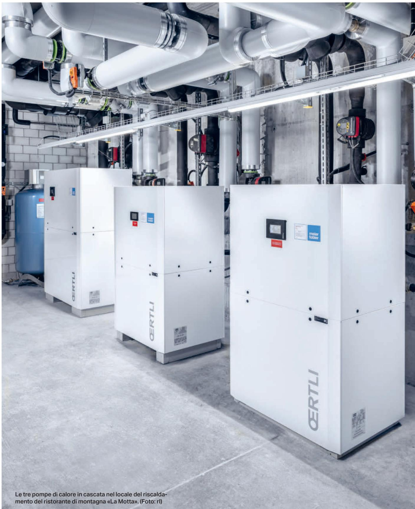
Le tre pompe di calore in cascata nel locale del riscaldamento del ristorante di montagna «La Motta». (Foto: rl)
