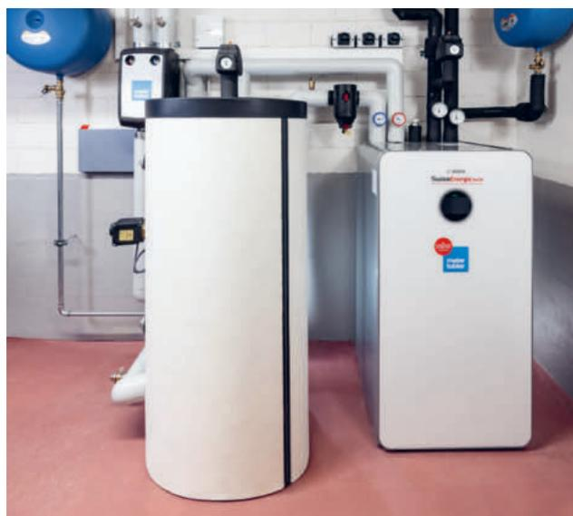
B0/W35 e l'accumulatore tampone tecnico Oertli IMPHSO «H 300». «Dato che era possibile mantenere la soluzione esistente per produrre l'acqua calda con l'energia solare termica, abbiamo quindi sostituito solo l'impianto di riscaldamento.», aggiunge Markus Schmid.
