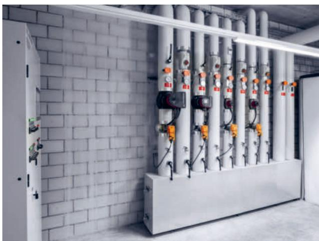
La distribuzione del calore con i quattro gruppi e, a sinistra, l'armadio di comando con il sistema di controllo.
