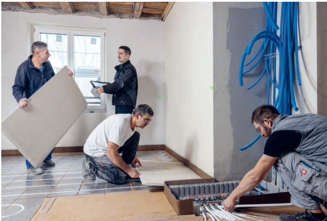
Das Fussbodenheizungs-Installations-Team unter der Leitung von Ermin Sadikovic (hinten Mitte) beim Verlegen (v.l.): Dido Zlotto, Slavko Jozac und Roman Cucu. (Bilder: rl)
