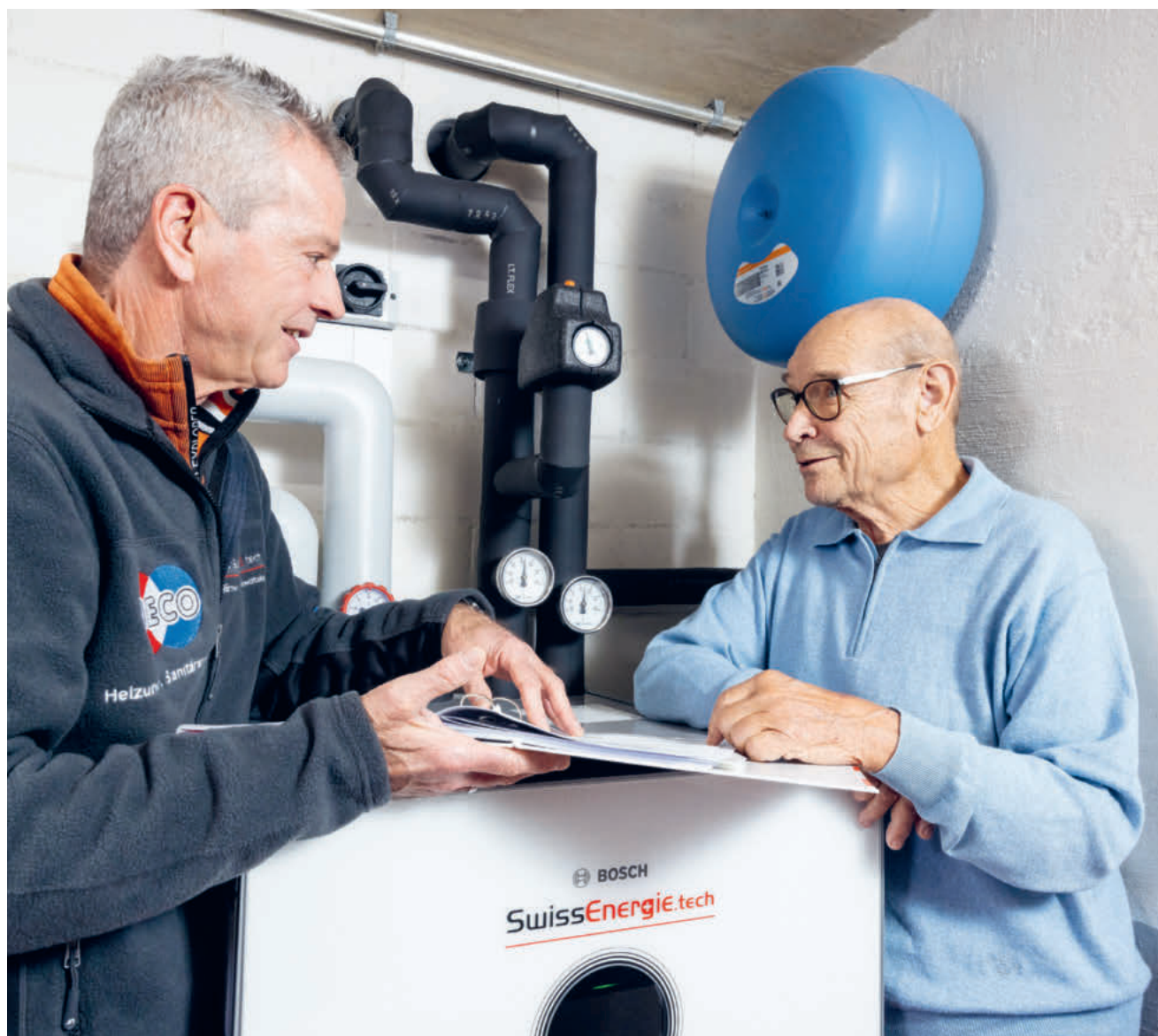
Un nouveau chauffage en une demi-heure : l'installateur Pius Sterki (à gauche) avec son client René Hess. (Photos : rl)
