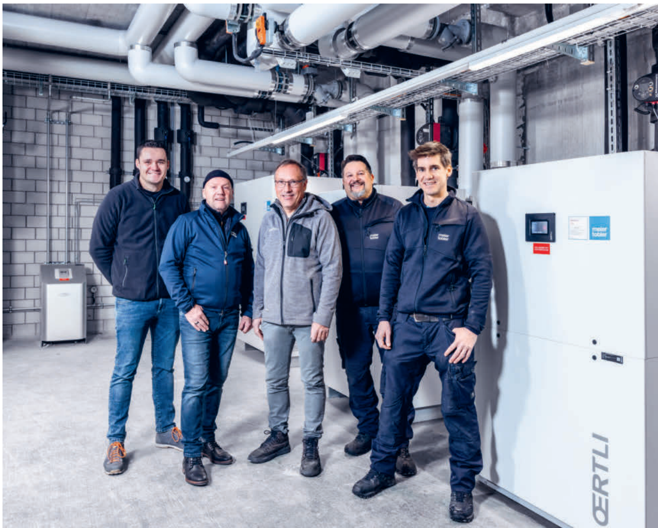
L'équipe de mise en œuvre dans la chaufferie située sous le restaurant La Motta (d. g. à d.): Manuel Feuerstein, Reto Gerschwiler, Dario Cao ainsi que du Service de Meier Tobler: Ernst Engi, responsable d'équipe des énergies renouvelables, et le technicien Sandro Bettini.
