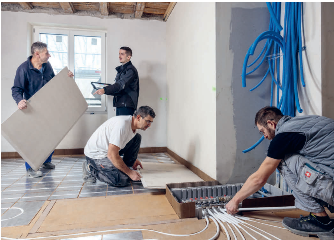
L'équipe d'installation du chauffage par le sol sous la direction d'Ermin Sadikovic (au fond au centre) lors de la pose (d.g. à d.): Dido Zlotto, Jozac Slavko et Roman Cucu. (Photos: rl)
