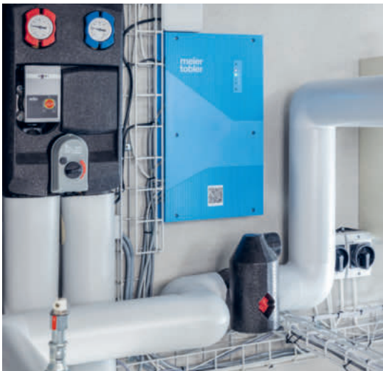
Vue d'ensemble de la nouvelle installation (en haut), avec l'évacuation de l'air (en haut à gauche) et la connexion SmartGuard.
