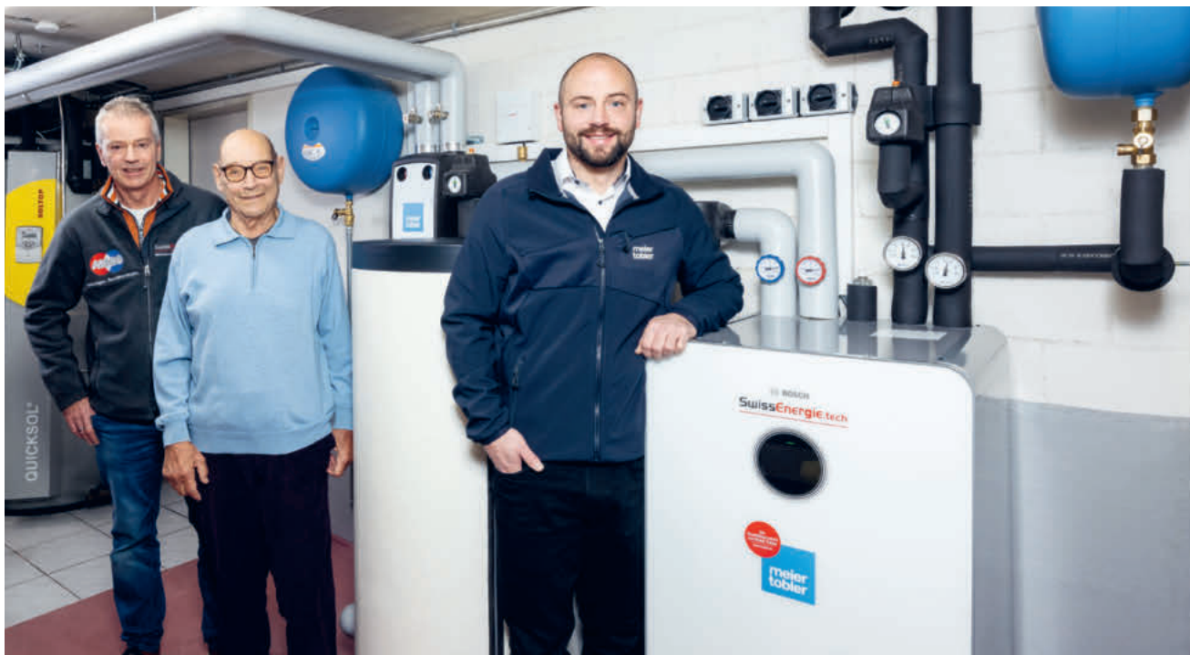
Une installation parfaitement mise en œuvre (ci-dessous) et une équipe de réalisation ravie (ci-dessus, d. g. à d.) : Pius Sterki, René Hess et Markus Schmid.
