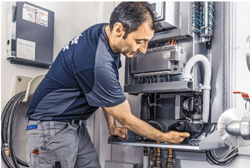
Links: Manuel Hidalgo bei der Reinigung der Inneneinheit. Links unten: Mit dem «Schmöcker» allfällige Lecks aufspüren. Unten: Stimmen die Messwerte? Manuel Hidalgo prüft die Ausseneinheit.
