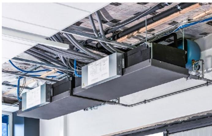
**Unten: Verbindet den Aussen- mit dem Innenkreislauf – der Hybrid-BC-Controller ist das Herzstück der Anlage.**
