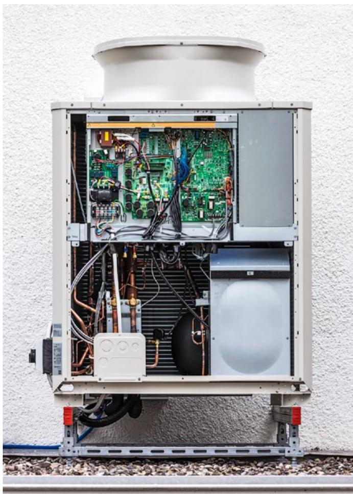
**Sopra: l'unità esterna City Multi sul tetto dell'autorimessa garantisce il raffreddamento del circuito esterno.**
