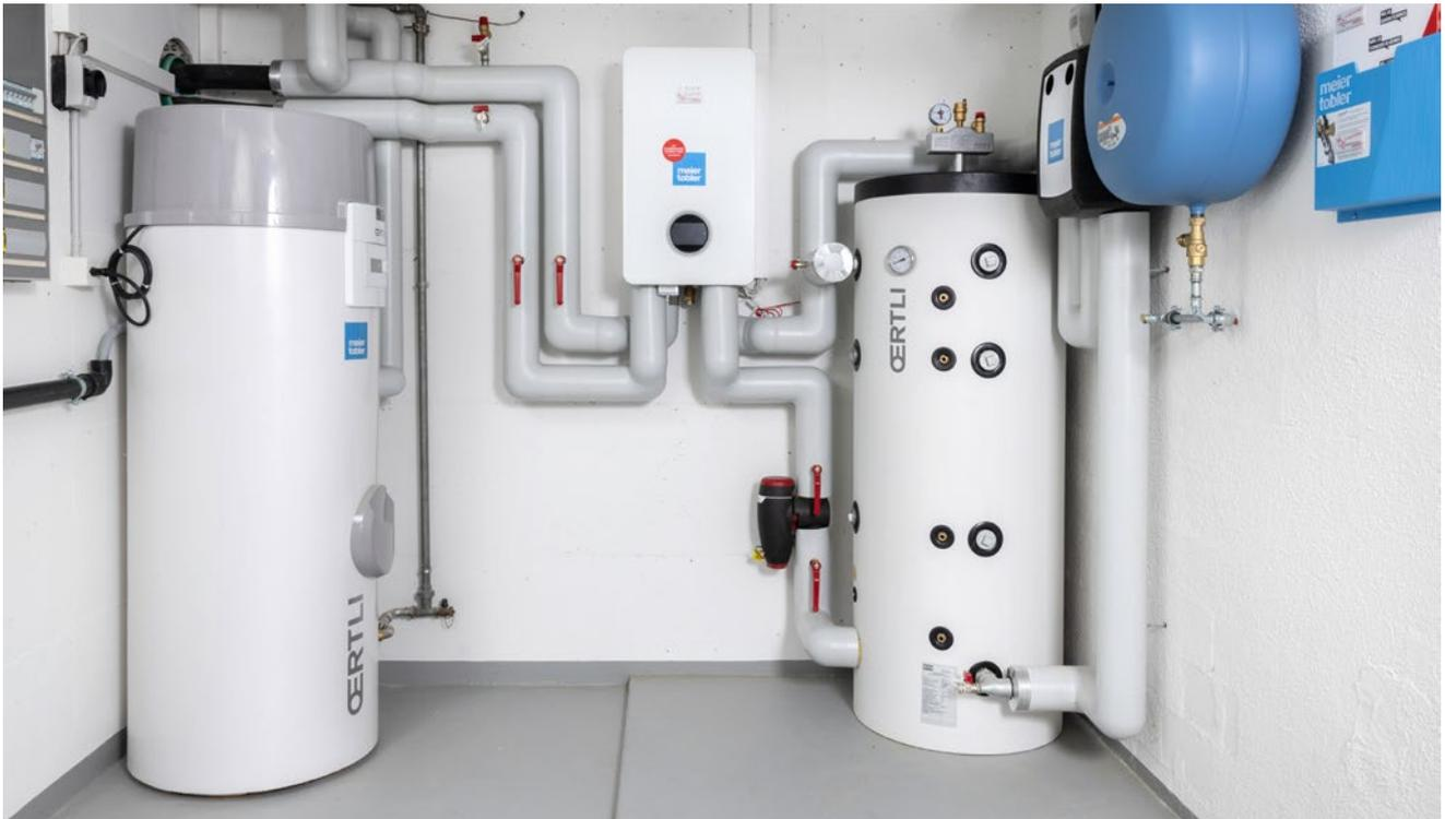
Der alte Heizkeller im neuen Glanz – mit (v.l.) Wärmepumpenboiler Oertli TWH 250EH Pro, Inneneinheit der Wärmepumpe sowie Wärmespeicher Oertli SHW 307.
