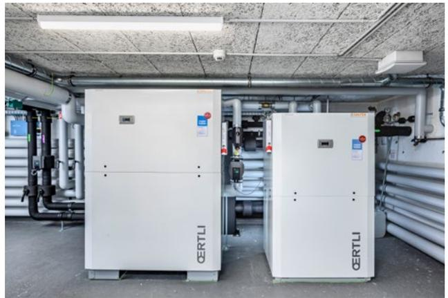
Le garage Jörg à Weesen (en haut à gauche) avec de nouvelles installations techniques : les aérothermes Orion (en haut à droite), les deux accumulateurs tampons Oertli SHW 807 (en bas à gauche) ainsi que les deux pompes à chaleur Oertli SIN 75TU et Oertli SINH 20TE (en bas à droite).
