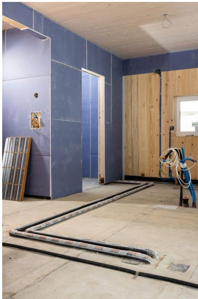
Posa del sistema Metalplast Compact-Oeko 30 al piano superiore (a sinistra) e del sistema Metalplast Compact-Plus 30 al piano terra.
