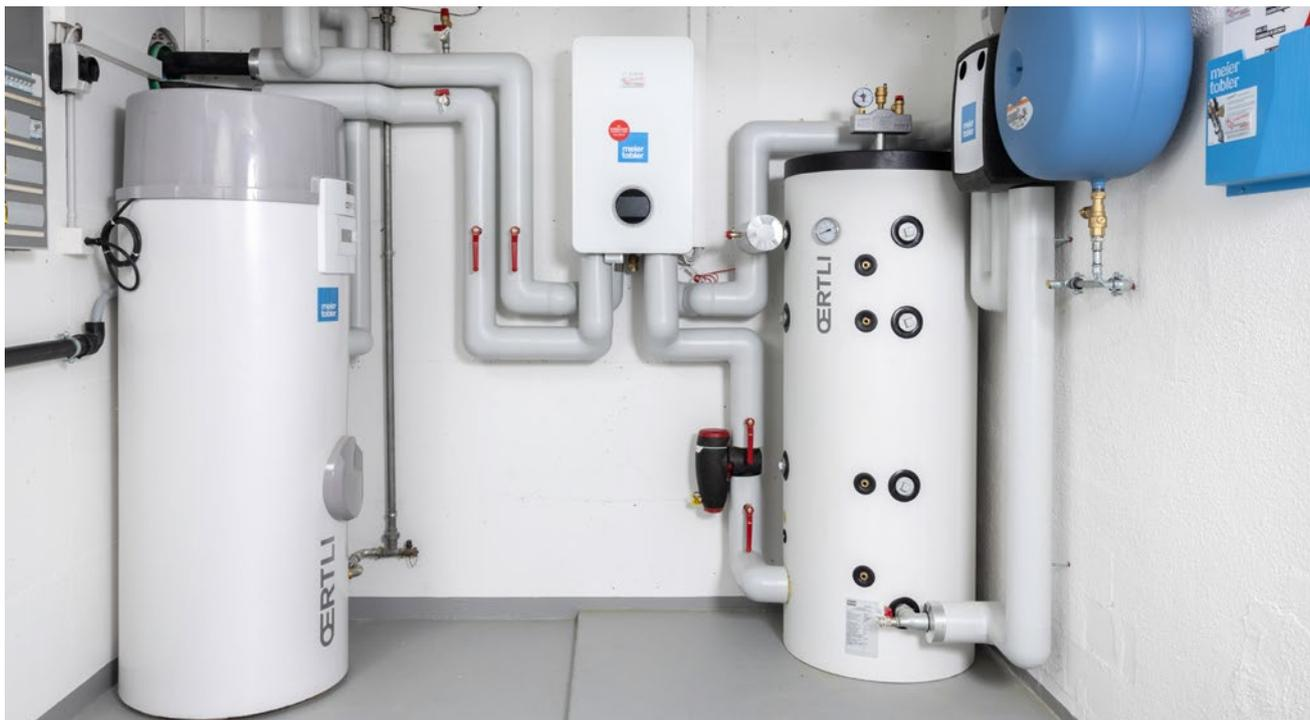
Il vecchio locale del riscaldamento in tutto il suo nuovo splendore (da s. a d.): il bollitore a pompa di calore Oertli TWH 250EH Pro, l'unità interna della pompa di calore e l'accumulatore di calore Oertli SHW 307.
