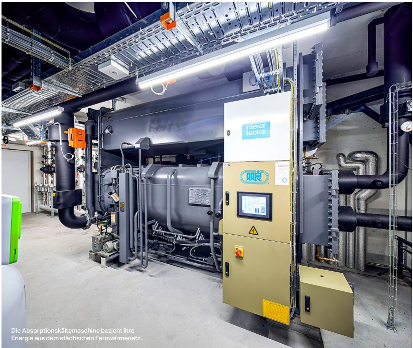
Die Absorptionskältemaschine bezieht ihre Energie aus dem städtischen Fernwärmenetz.
