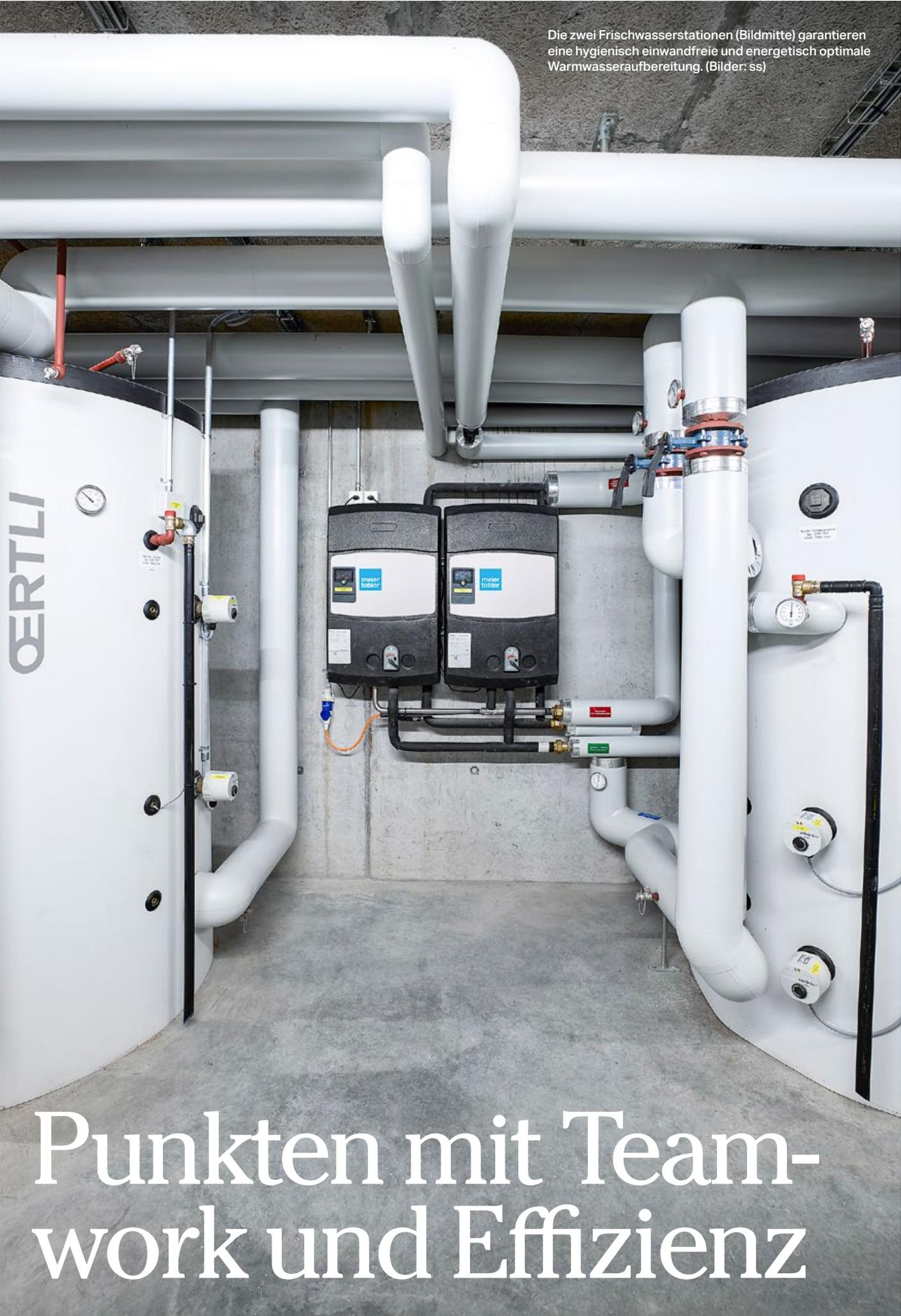
Die zwei Frischwasserstationen (Bildmitte) garantieren eine hygienisch einwandfreie und energetisch optimale Warmwasseraufbereitung. (Bilder: ss)
