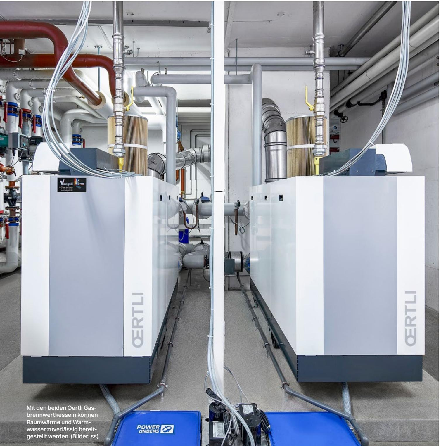
Mit den beiden Oertli Gasbrennwertkesseln können Raumwärme und Warmwasser zuverlässig bereitgestellt werden. (Bilder: ss)
