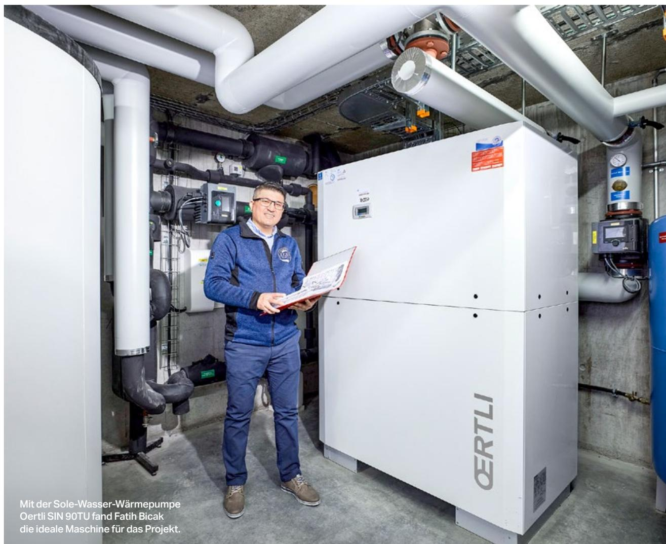
Mit der Sole-Wasser-Wärmepumpe Oertli SIN 90TU fand Fatih Bicak die ideale Maschine für das Projekt.
