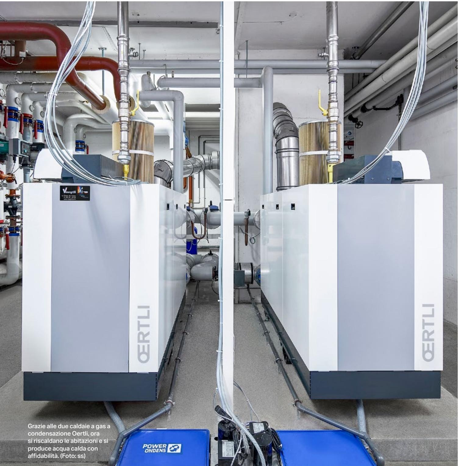
Grazie alle due caldaie a gas a condensazione Oertli, ora si riscaldano le abitazioni e si produce acqua calda con affidabilità. (Foto: ss)
