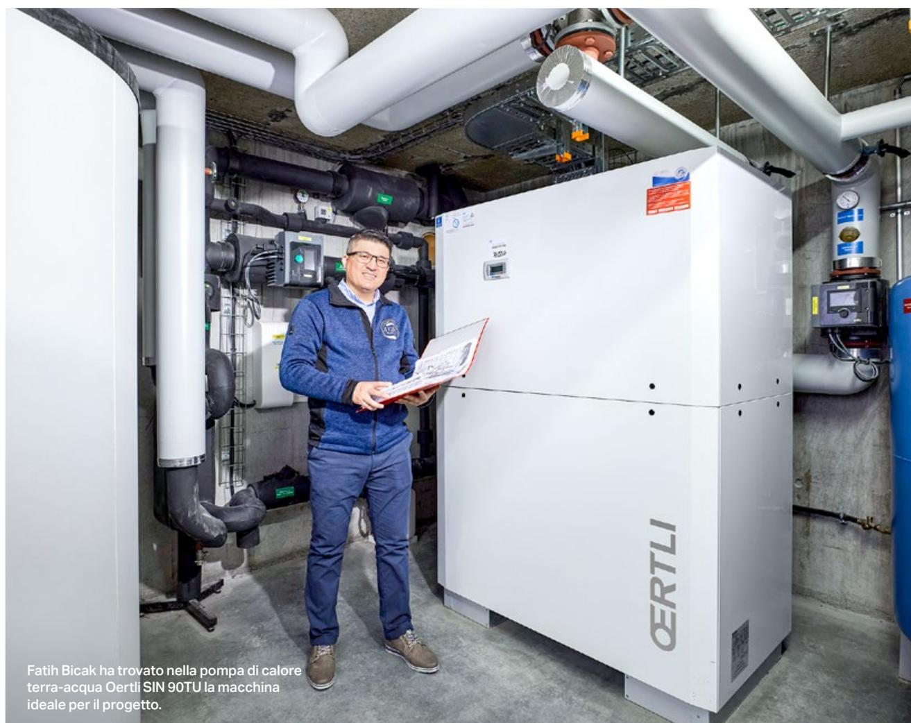
Fatih Bicak ha trovato nella pompa di calore terra-acqua Oertli SIN 90TU la macchina ideale per il progetto.
