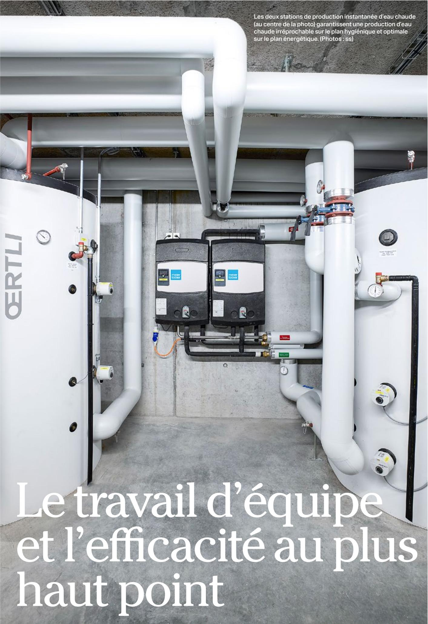
Les deux stations de production instantanée d'eau chaude (au centre de la photo) garantissent une production d'eau chaude irréprochable sur le plan hygiénique et optimale sur le plan énergétique. (Photos : ss)
