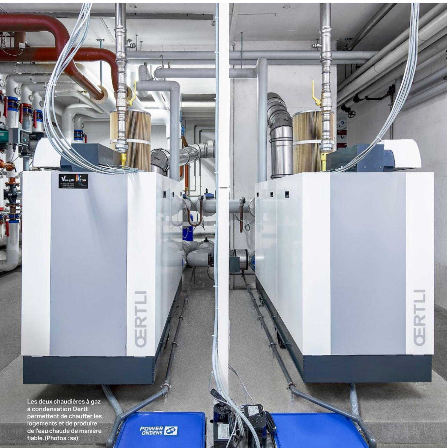
Les deux chaudières à gaz à condensation Oertli permettent de chauffer les logements et de produire de l'eau chaude de manière fiable. (Photos : ss)
