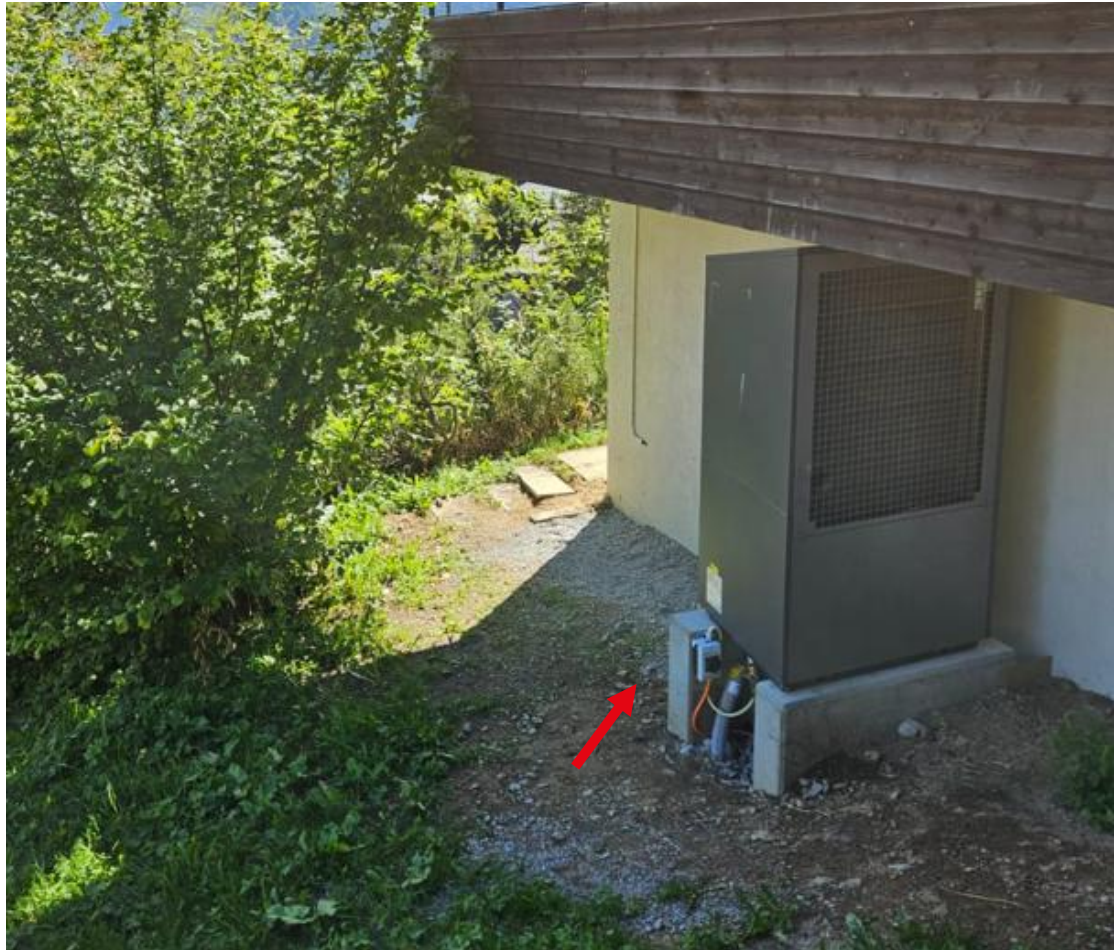
Wärmepumpe Luft/Wasser Oertli LAN 33TPR
