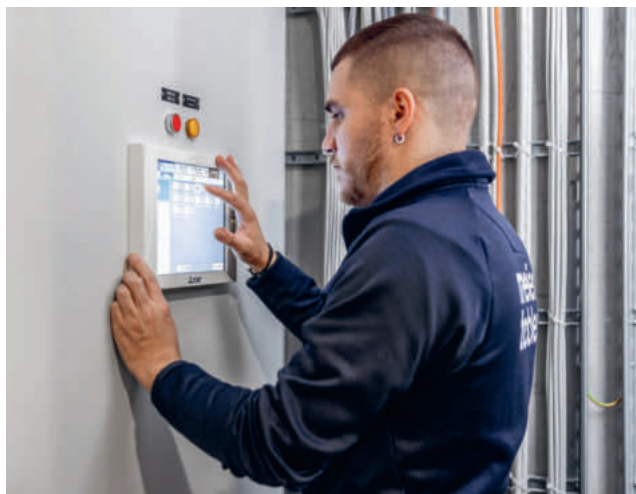
Il nuovo impianto (in basso a sinistra) sul tetto del centro trasfusionale di Losanna-Epalinges (in alto a destra) offre maggiore sicurezza e comfort a gestori, personale e pazienti. La distribuzione avviene per mezzo di cassette a quattro vie. Direttamente sul posto è stato installato uno schermo del comando centralizzato, in modo che l'impianto possa essere monitorato e controllato da Hugo Tiago Couto Da Silva (immagine in basso a destra).
