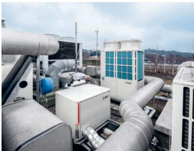
Il nuovo impianto (in basso a sinistra) sul tetto del centro trasfusionale di Losanna-Epalinges (in alto a destra) offre maggiore sicurezza e comfort a gestori, personale e pazienti. La distribuzione avviene per mezzo di cassette a quattro vie. Direttamente sul posto è stato installato uno schermo del comando centralizzato, in modo che l'impianto possa essere monitorato e controllato da Hugo Tiago Couto Da Silva (immagine in basso a destra).
