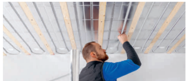
Les panneaux modulaires metalplast-compact-pet 30 sont particulièrement adaptés à une pose au plafond, non seulement pour chauffer, mais aussi pour refroidir. Ils conviennent également à une utilisation sur les murs et les sols.
