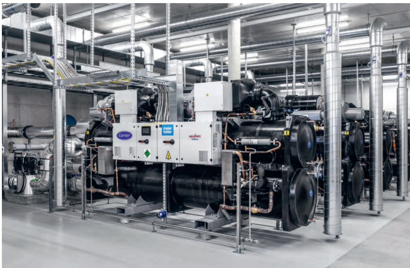
Eindrücklich: die vier starken Carrier Aquaforce 61 XWHL-ZE 17 Grosswärmepumpen von Meier Tobler. (Bilder: rl)
