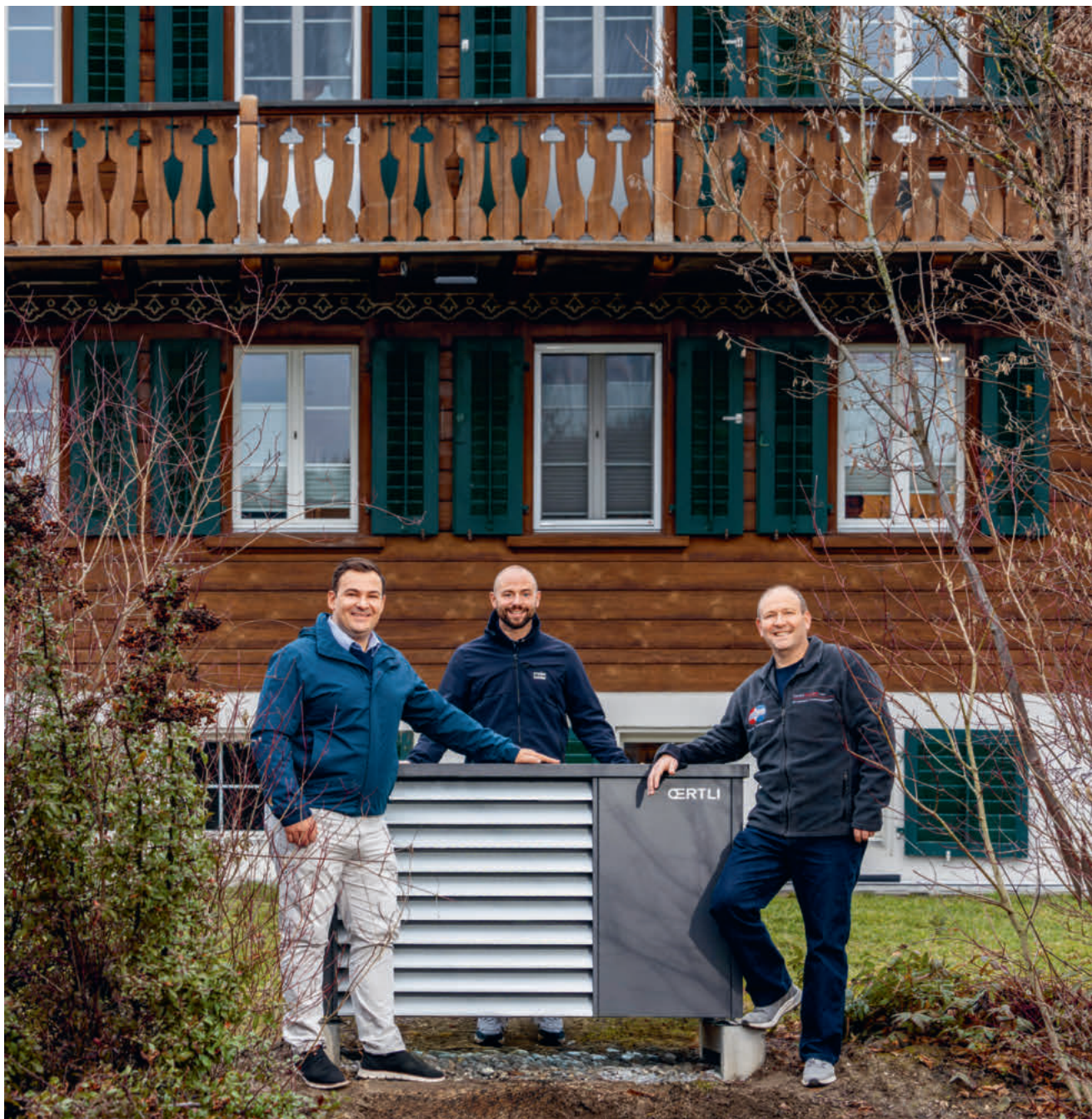
Patrick Läng (links), Markus Schmid (Mitte) und Marco Meier (rechts) mit der Ausseneinheit der neuen Luft-Wasser-Wärmepumpe Oertli Aero 2-8a im Garten des fast 100 Jahre alten Hauses. (Bilder: rl)
