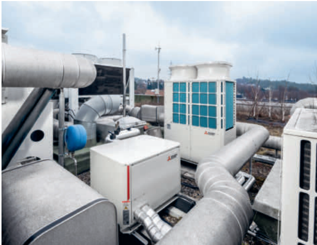
Die neue Anlage (links unten) auf dem Dach des Blutspendezentrums Lausanne-Epalinges (rechts oben) bringt den Betreibern, Mitarbeitenden und Patientinnen und Patienten mehr Sicherheit sowie mehr Komfort. Die Verteilung erfolgt über die 4-Wege-Kassetten. Direkt vor Ort ist ein Display der zentralen Steuerung angebracht, sodass die Anlage von Hugo Tiago Couto Da Silva überwacht und gesteuert werden kann (Bild rechts unten).
