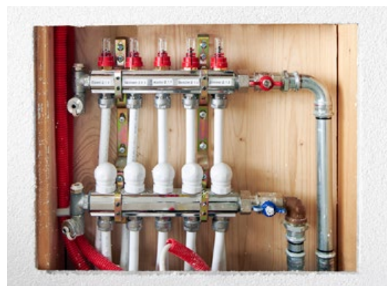
Il distributore del sistema di riscaldamento a pavimento.
