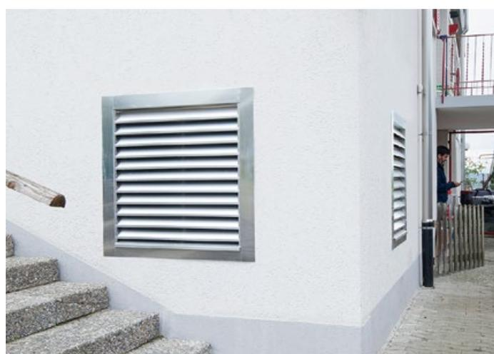
Vue extérieure de l'entrée et de la sortie d'air de part et d'autre du coin.
