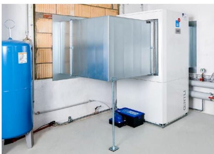
Wärmepumpe mit Luftkanal und Kondensatbox.
