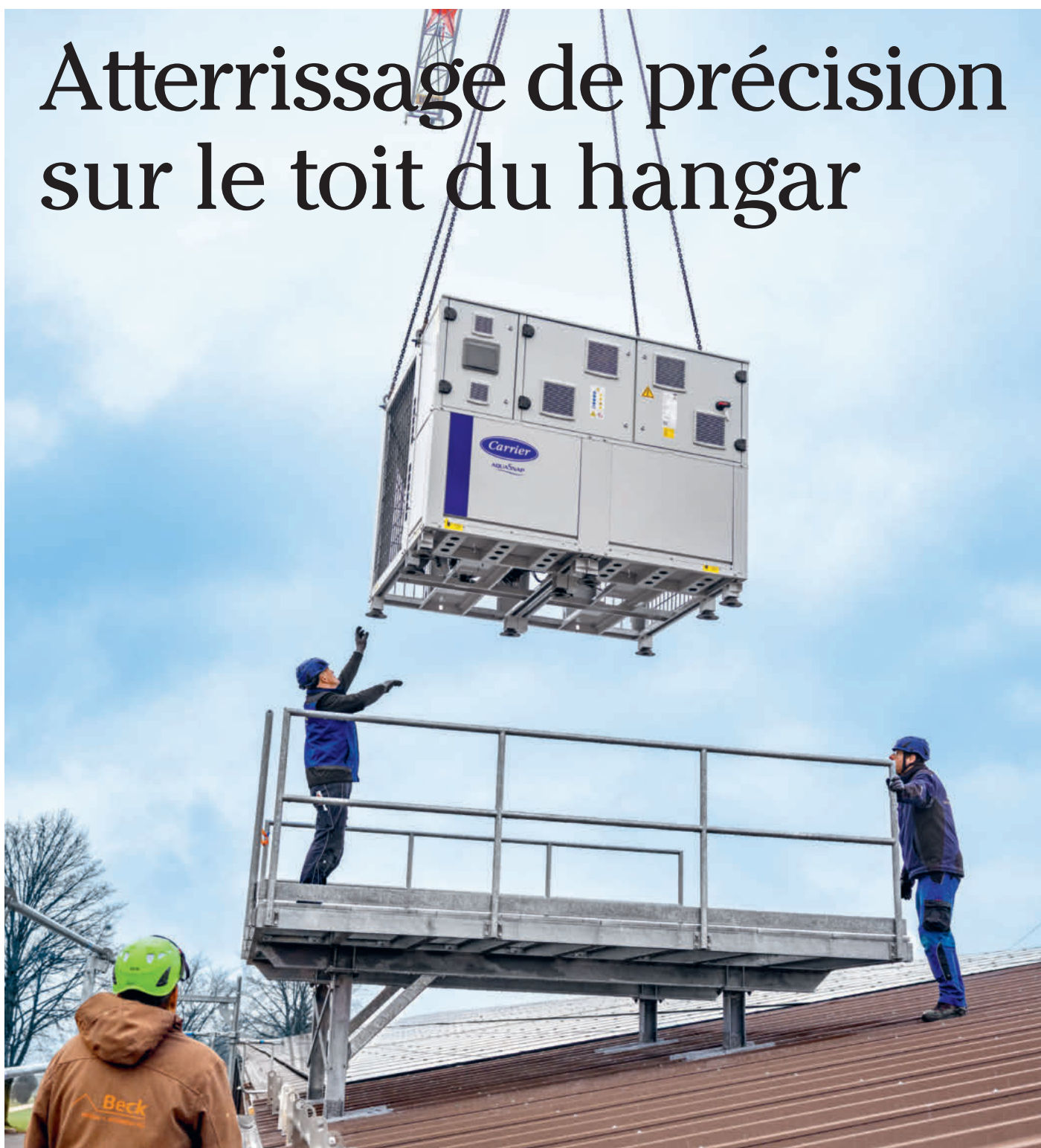
Grande pompe à chaleur en approche : précision et habileté à l'arrivée sur le toit du hangar. (Photos : rl)
