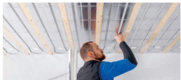
Les panneaux modulaires metalplast compact-pet 30 sont particulièrement adaptés à une pose au plafond, non seulement pour chauffer, mais aussi pour refroidir. Ils conviennent également à une utilisation sur les murs et les sols.
