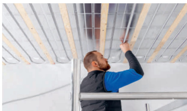
metalplast-compact-pet-30-Systemplatten eignen sich besonders gut für den Einsatz an Decken, um nicht nur zu heizen, sondern auch zu kühlen. Ebenso gut eignen sie sich für den Einsatz an Wänden und Böden.
