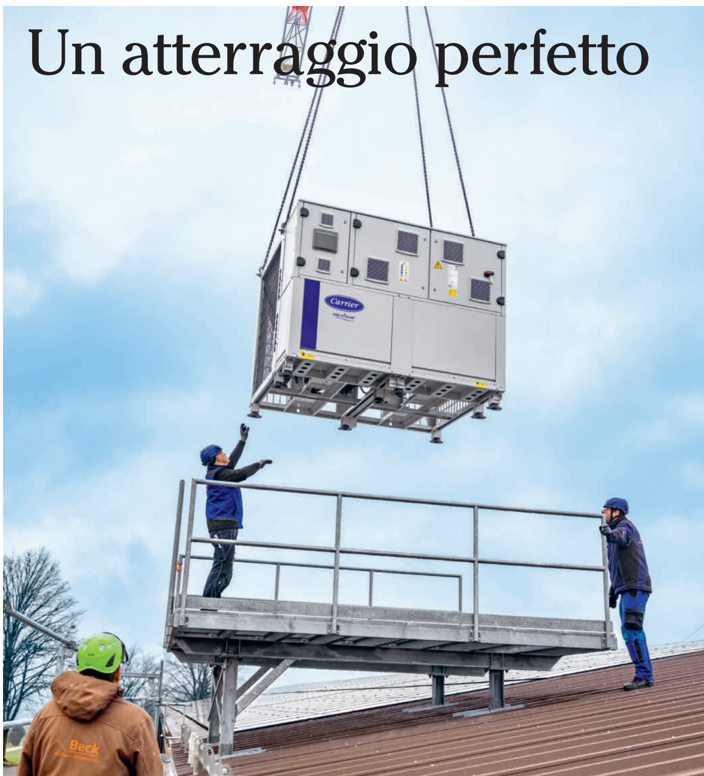
La grande pompa di calore prossima all'atterraggio: precisione e destrezza all'arrivo sul tetto dell'hangar. (Foto: rli)
