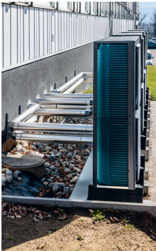
Colloquio davanti all'edificio aziendale (da sin.): Laurent Solari, Matteo Conti e Rodolfo Bianchi (sopra). Installazione ordinata tra le quattro pompe di calore e il locale caldaia (a destra).
