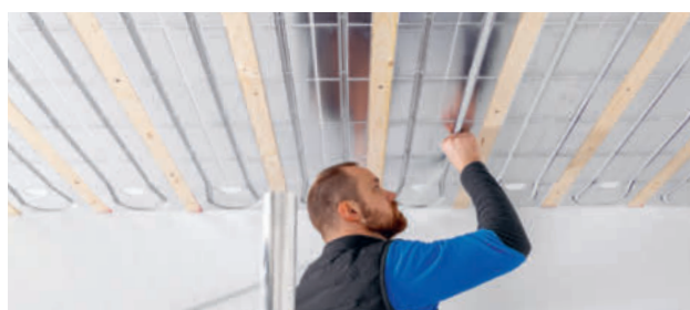
Piastra di sistema metalplast compact-pet 30: la soluzione sostenibile per pavimenti, pareti e soffitti.
