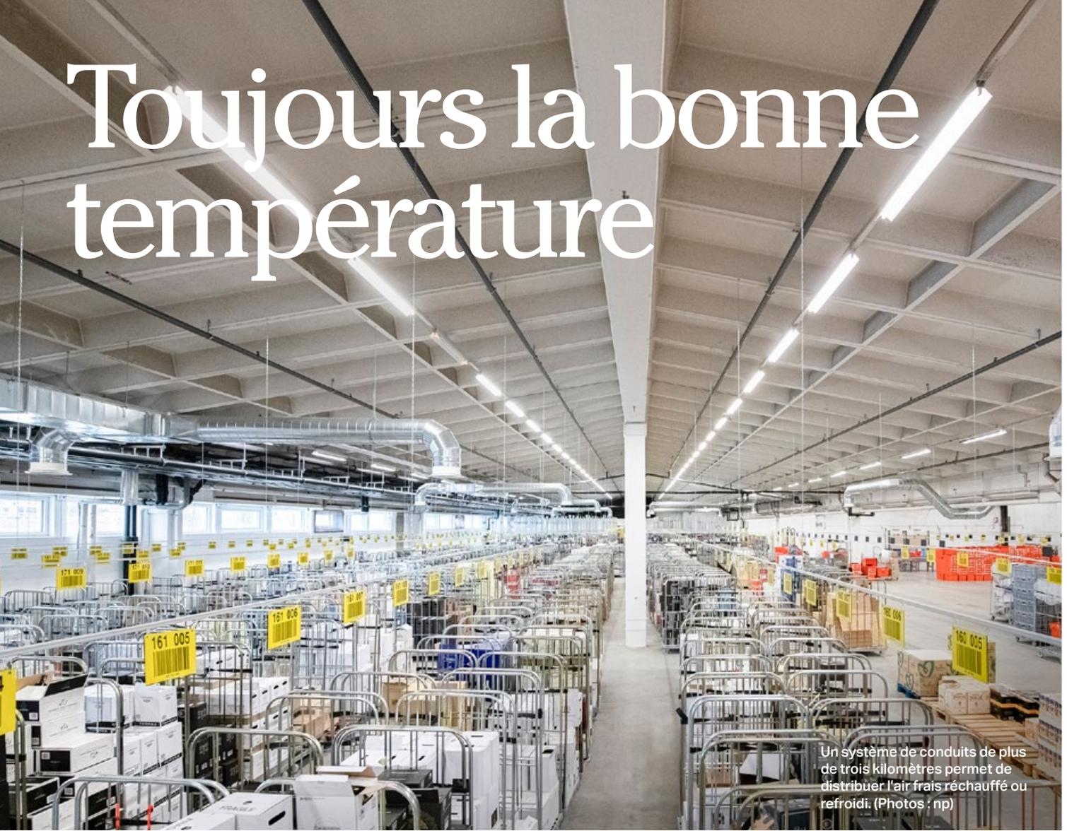
Un système de conduits de plus de trois kilomètres permet de distribuer l'air frais réchauffé ou refroidi. (Photos : np)
