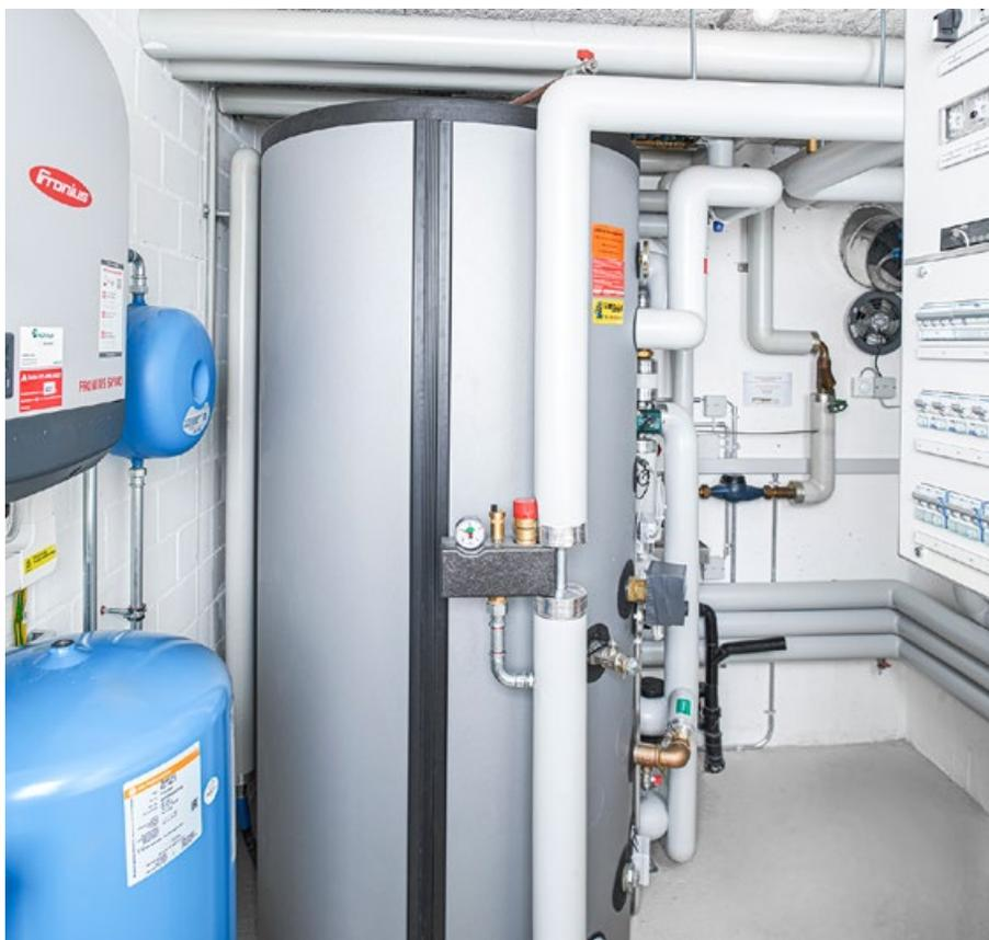
En haut : un système complexe, une mise en œuvre simple. L'onduleur et le vase d'expansion (à gauche), l'accumulateur combiné (au centre) et à droite le tableau avec le gestionnaire solaire Smartfox Pro.
