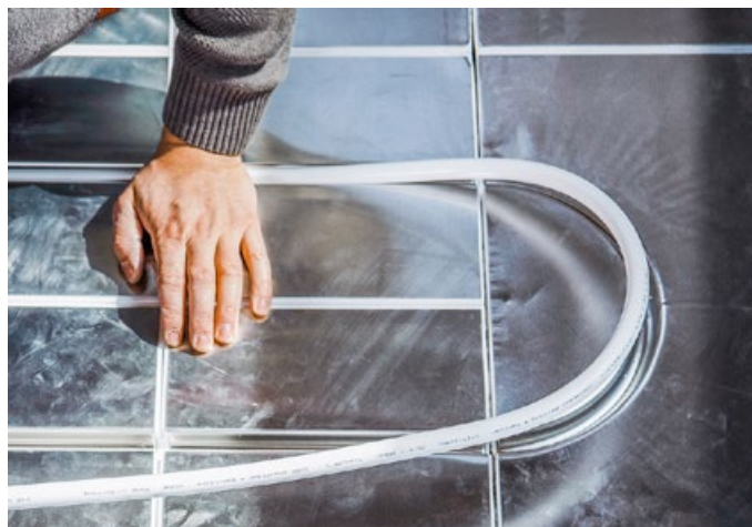
Realizzazione del canale nel supporto in polistirene (a sinistra) e posa del tubo flessibile negli elementi metalplast (a destra).
