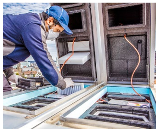
Unità esterna aperta: Abdul Al-Fayek mentre controlla e sostituisce il filtro.
