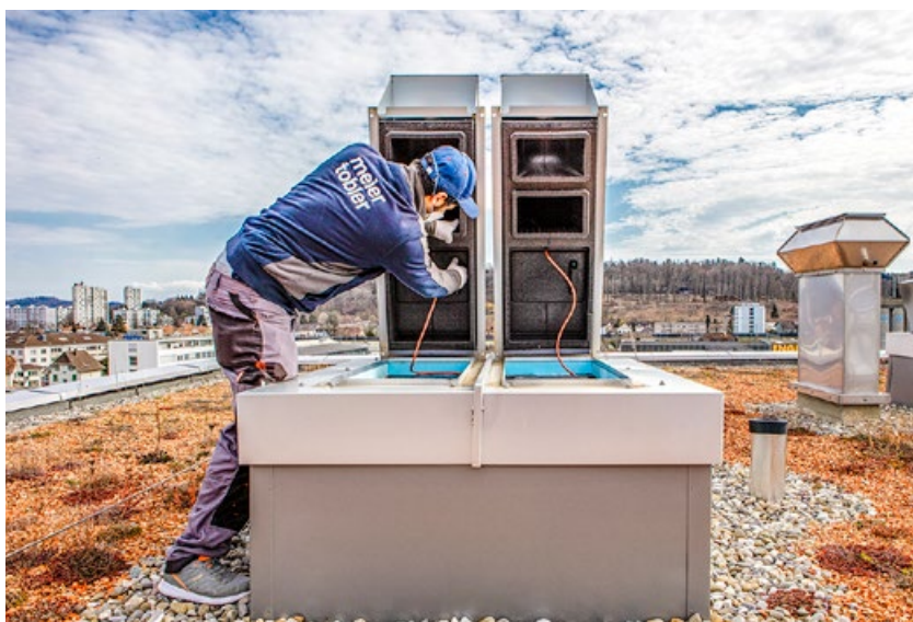
Unità esterna aperta: Abdul Al-Fayek mentre controlla e sostituisce il filtro.
