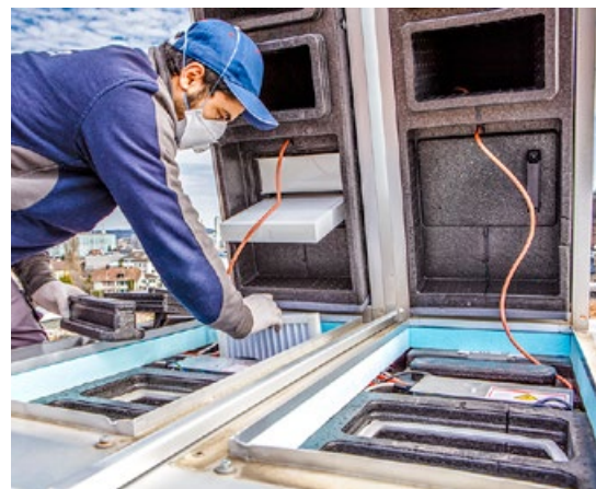
Klappen auf: Abdul Al-Fayek bei der Kontrolle und beim Wechsel des Filters.
