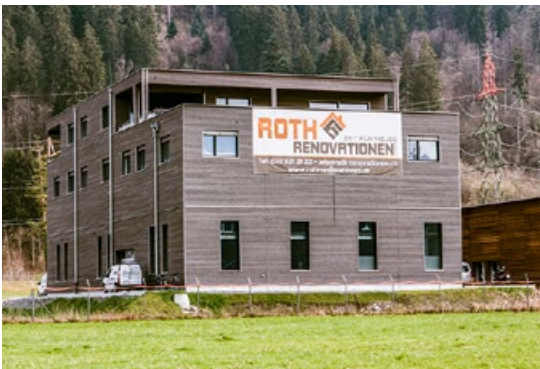
Das fertige Gebäude mit Werkhalle, Büros und Wohnung.
