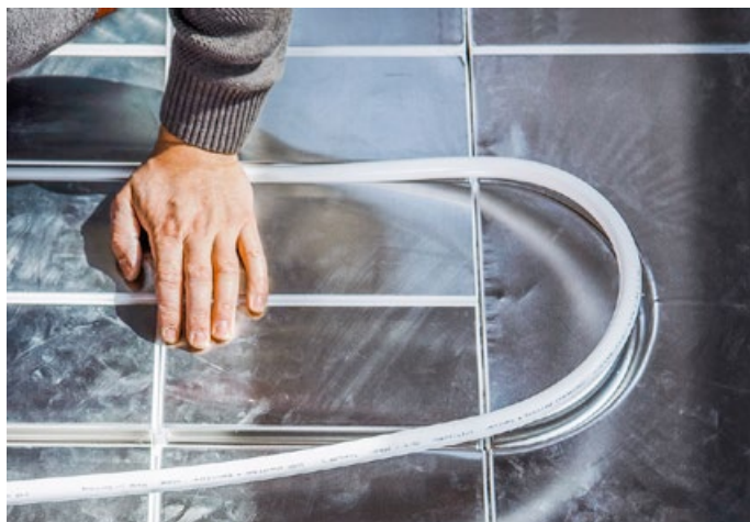
Erstellen des Kanals in der Styropor-Unterlage (links) und Verlegen des Schlauchs in den Metalplast-Elementen (rechts).
