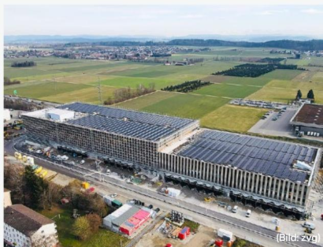
Das DCO mit der Photovoltaikanlage auf dem Dach in einer Luftaufnahme mit Blick von Nord nach Süd.
